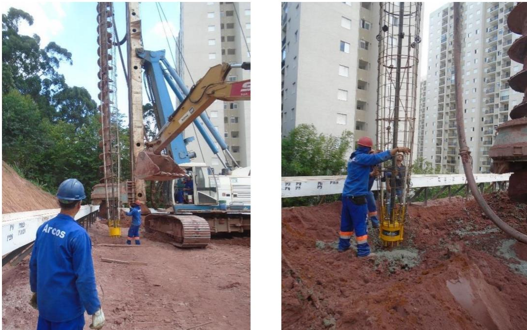
Figura 13 - Colocação da armadura junto a célula expansiva em Estaca Hélice Contínua
