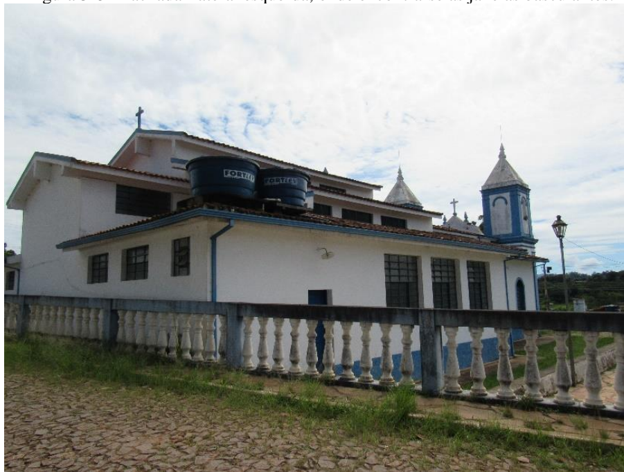
Figura 3-8 - Fachada Lateral esquerda, onde encontra-se as janelas basculantes.
