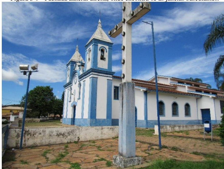
Figura 3-9 - Fachada Lateral direita, onde encontra-se as janelas basculantes.
