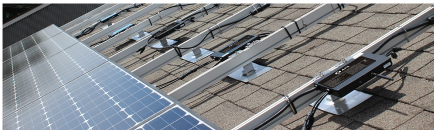
Figura 28 - Instalação de Microinversores à Estrutura
