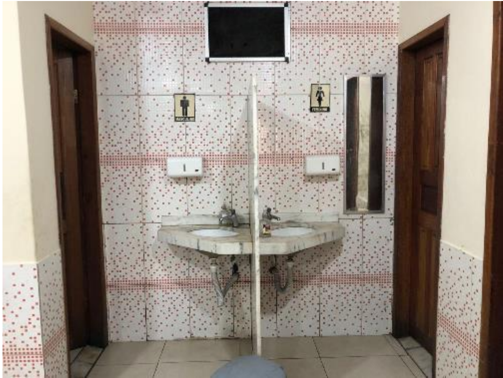
Figura 14 Foto da parte de fora do banheiro após a pintura.
