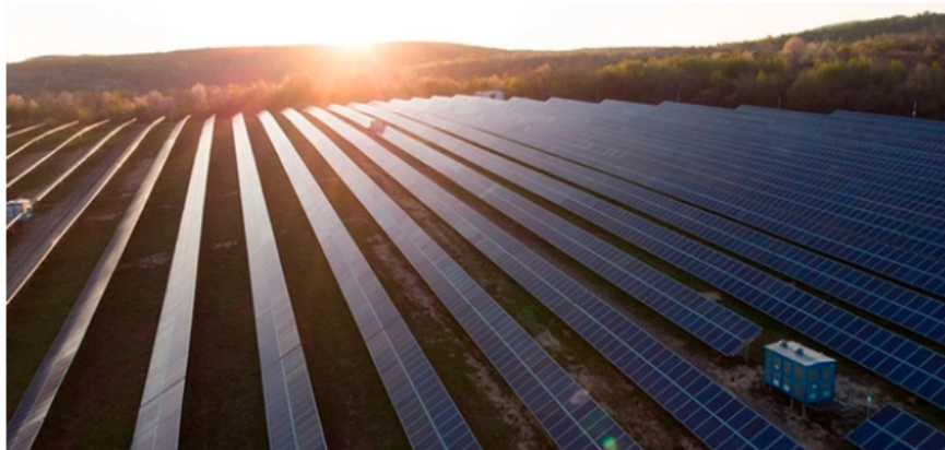
Figura 7 – Exemplo de Geração Centralizada fotovoltaica.
