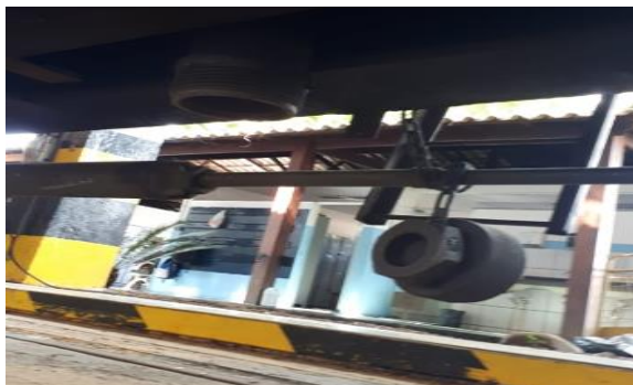
Figura 37 - Sistema de descarga do vagão tanque
