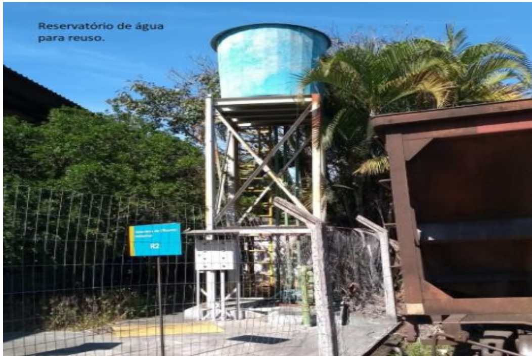
Figura 5 – Reservatório de água para reúso
