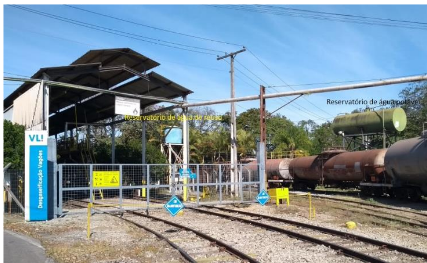
Figura 3 – Galpão destinado ao monitoramento da lavagem de vagões-tanques
