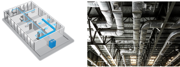
Figura 2.6 – Condicionador de ar do tipo central.
