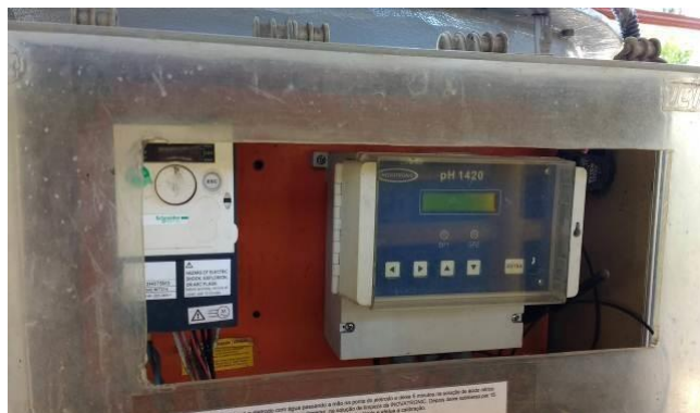
Figura 25 – Inversor de frequência do pHmetro de linha
