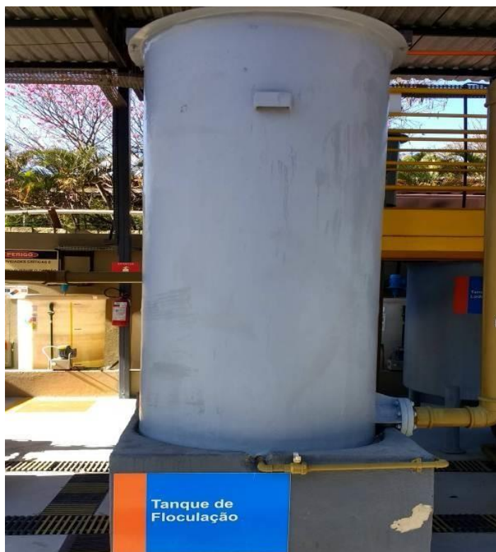
Figura 26 – Tanque de flocculação
