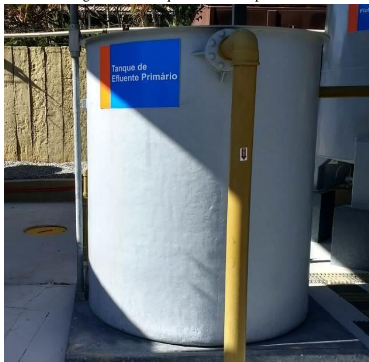
Figura 28 – Tanque de efluente primário
