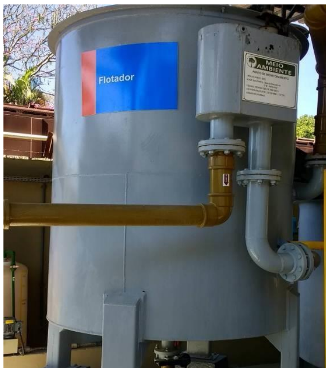
Figura 27 – Tanque de flotação e raspagem de lodo físico-químico
