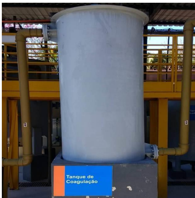
Figura 24 – Tanque de coagulação
