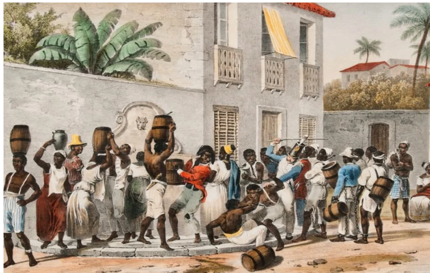
Figura 2 - Implantação de sistemas de canalização para o abastecimento hídrico no Rio de Janeiro.
