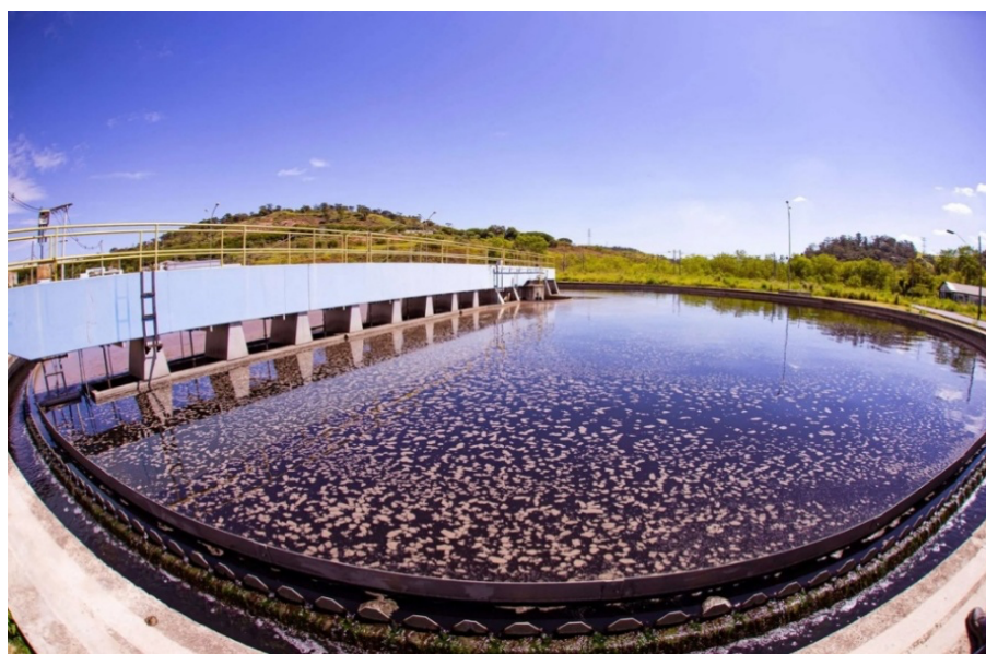
Figura 7 - Decantador secundário da Estação de Tratamento de Esgoto Arrudas, em Belo Horizonte - MG
