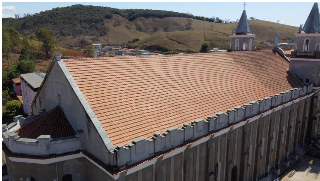
Figura 15: Processo de limpeza das telhas da Matriz.
