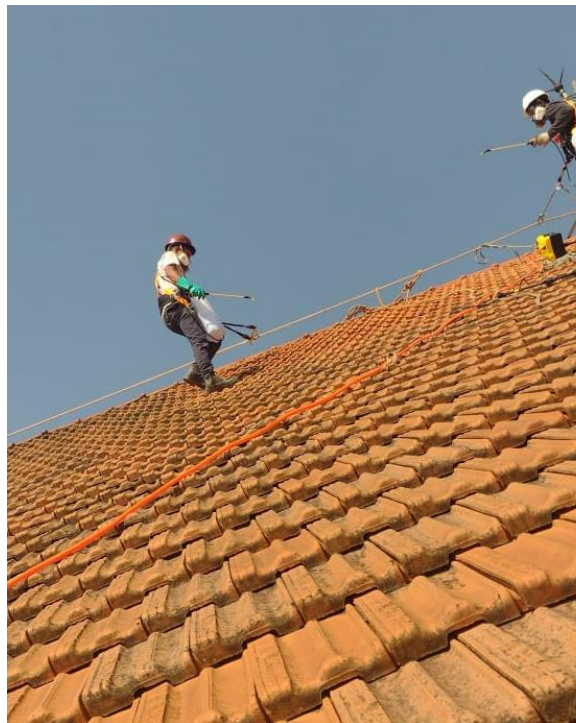
Figura 16: Profissionais realizando a limpeza das telhas francesas.
