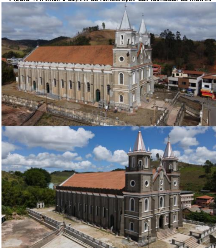
Figura 45: Antes e depois da restauração das fachadas da matriz.
