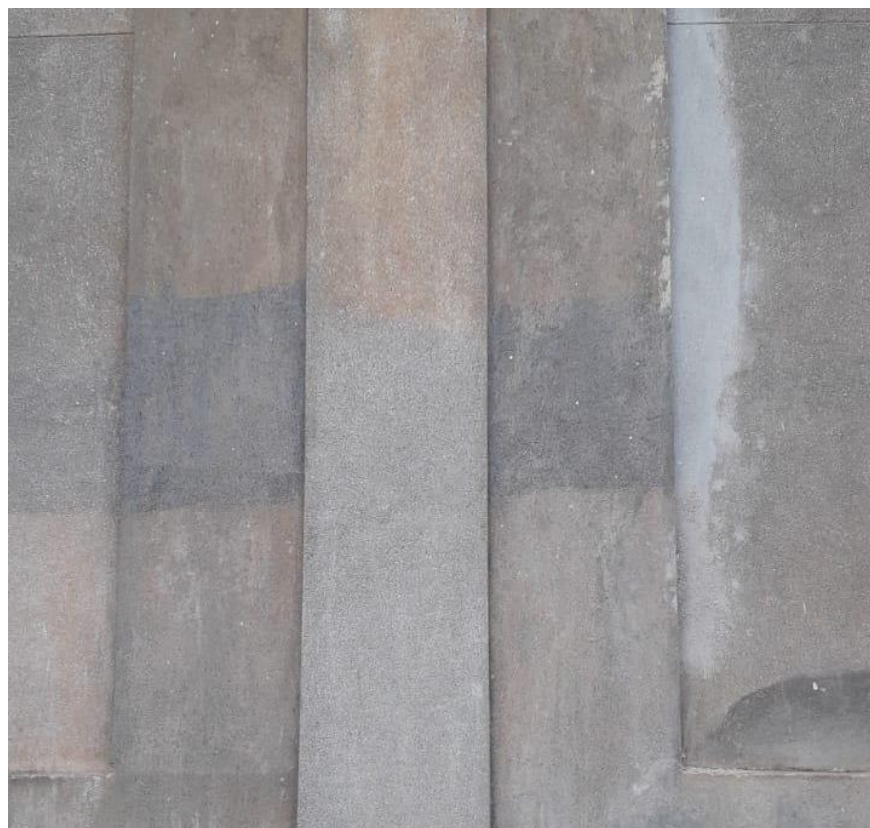
Figura 24: Teste de limpeza realizado sobre o revestimento original, com o objetivo de ressaltar sua tonalidade e avaliar a resposta superficial ao procedimento.
