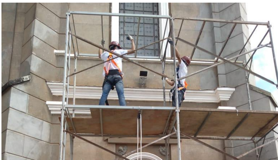
Figura 42: Montagem dos andaimes fachadeiros.
