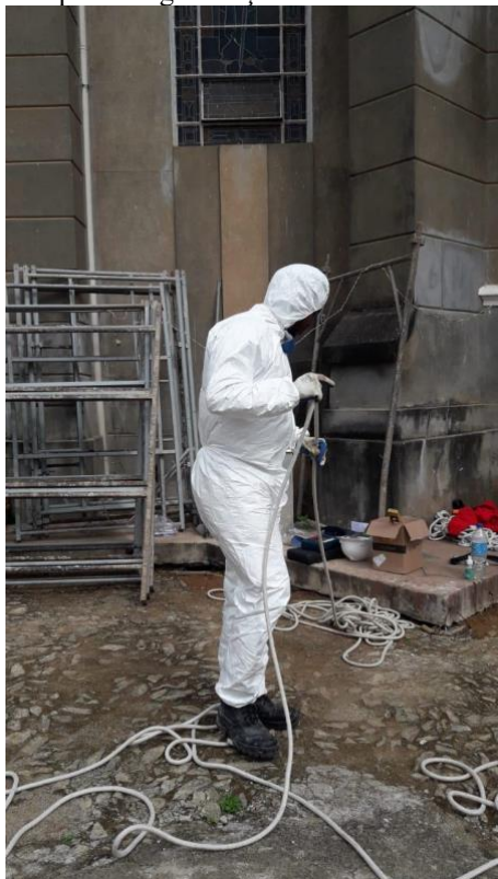
Figura 43: Preparação de equipamentos e materiais para a higienização das fachadas.
