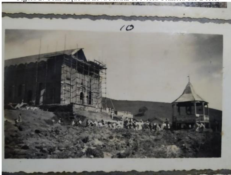
Figura 2: Construção da nova Matriz de Nossa Senhora das Dores.
