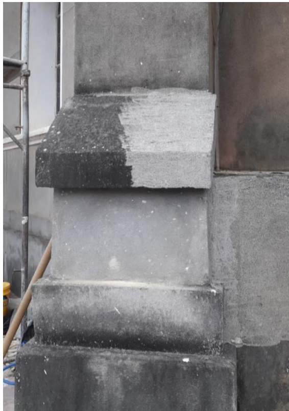
Figura 44: Limpeza de manchas escurecidas, com biocida.
