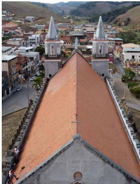
Figura 17: Processo de impermeabilização das telhas.
