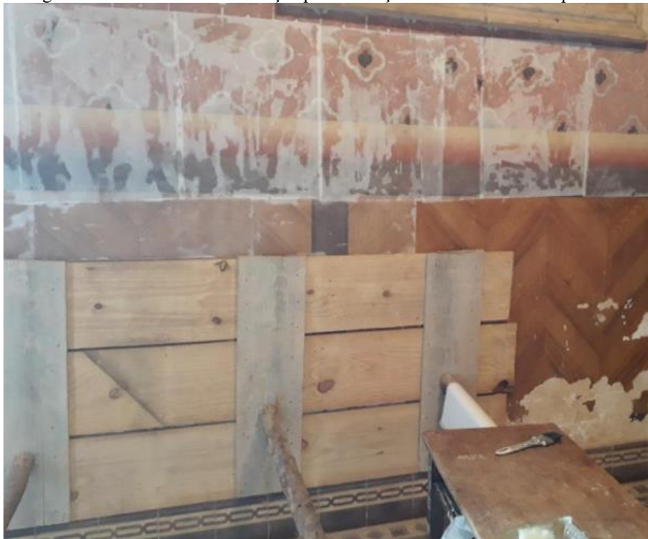
Figura 10: Processo de consolidação para refixação de revestimento desprendido.
