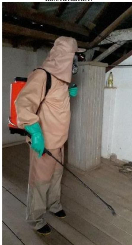
Figura 14: Profissional paramentado para fazer aplicação do descupinizada nas áreas de madeiramento.
