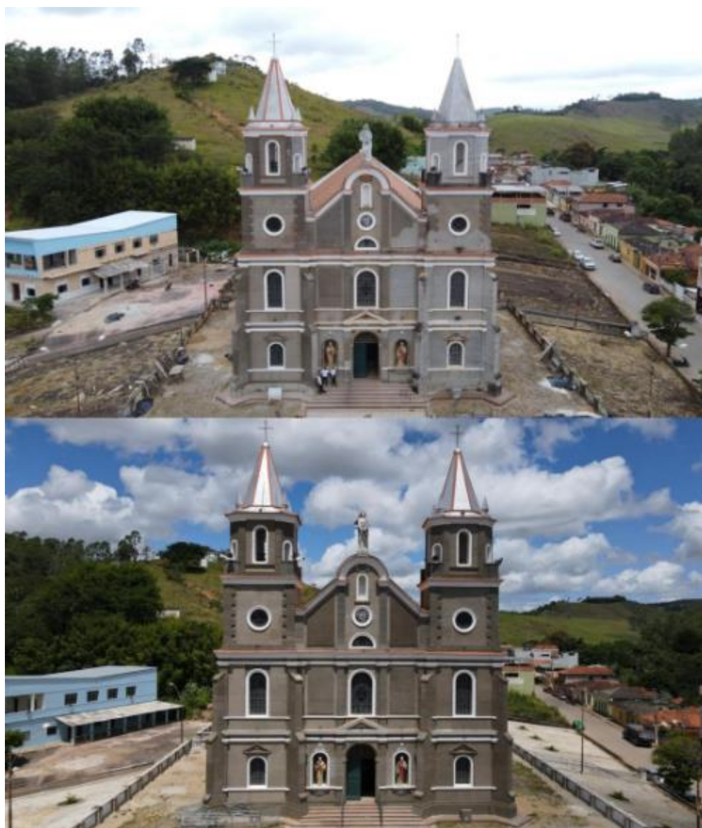
Figura 46: Antes e depois, fachada principal.
