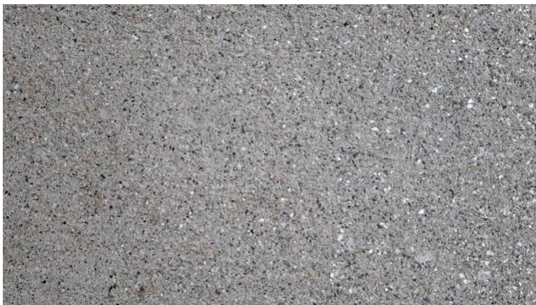
Figura 20: Vista aproximada do revestimento original, destacando a textura mineral e a distribuição heterogênea dos agregados.
