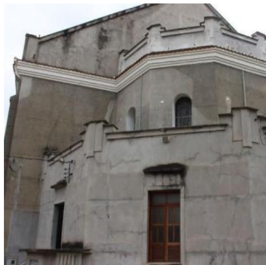
Figura 36: Fissurações no revestimento.
