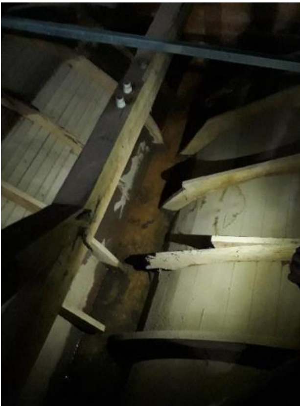
Figura 13: Interior do sótão, onde abriga a estrutura do forro e do telhado.
