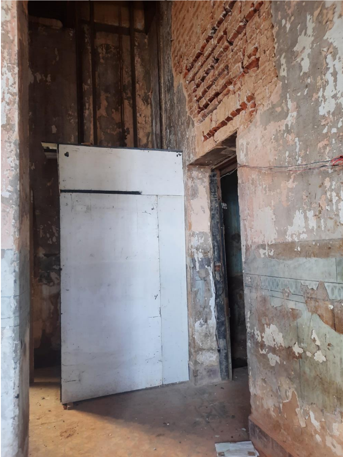
Figura 27 - Elevador protegido após início das obras
