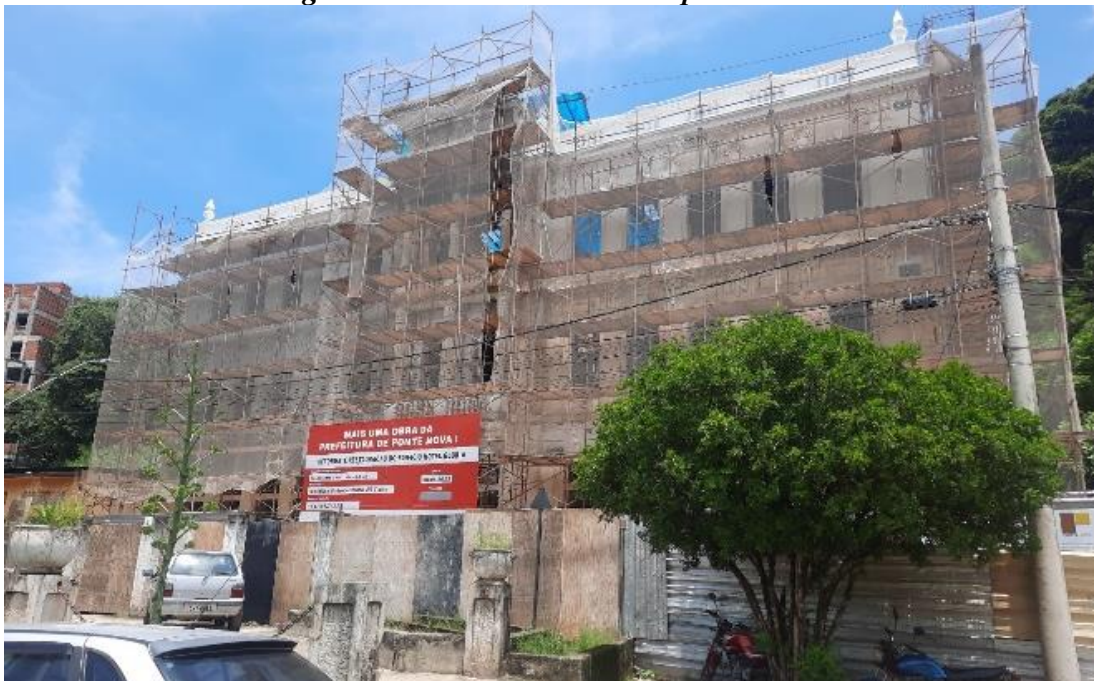
Figura 22 - Fachada Frontal após início das obras
