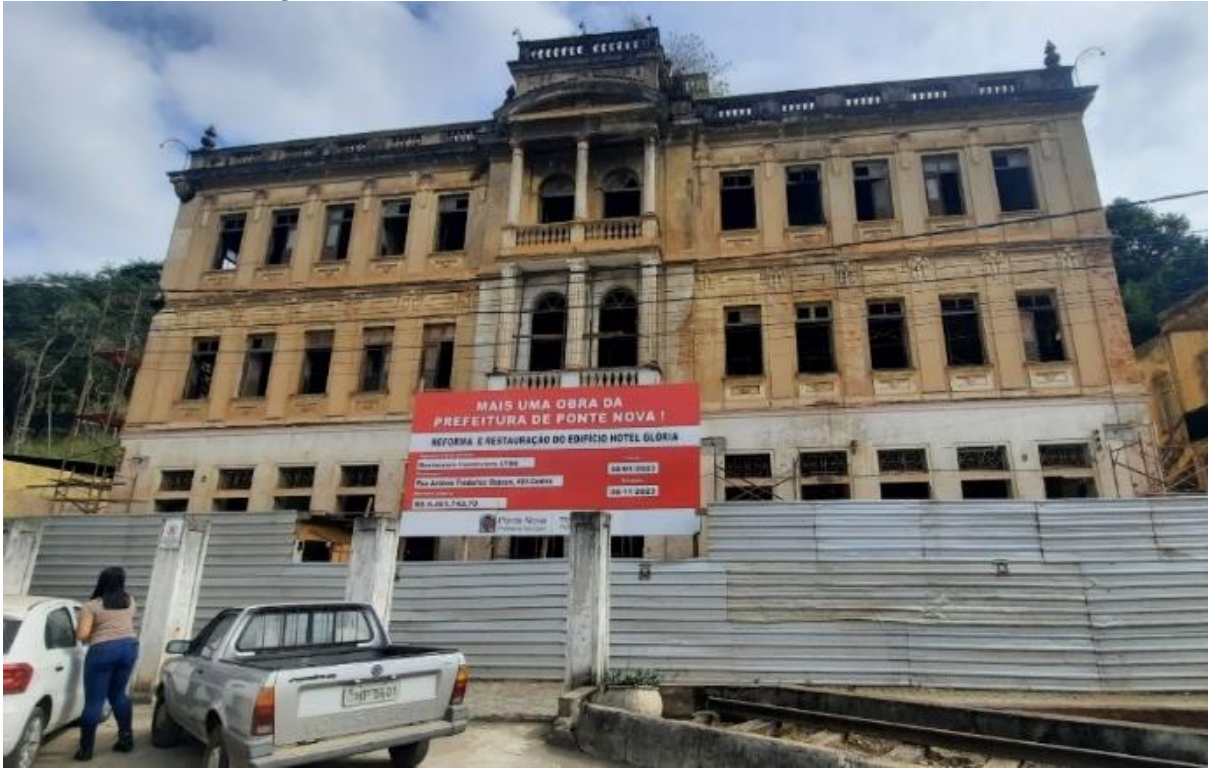
Figura 11 – Fachada Frontal antes do início das obras
