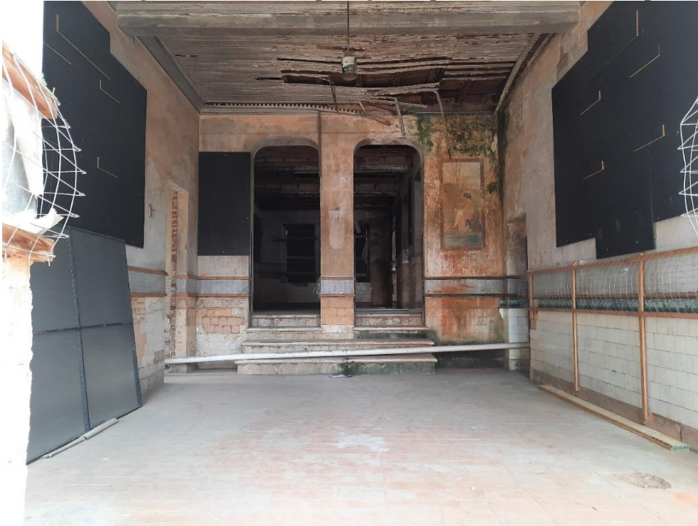
Figura 24 - Pinturas protegidas após início das obras 1º pavimento
