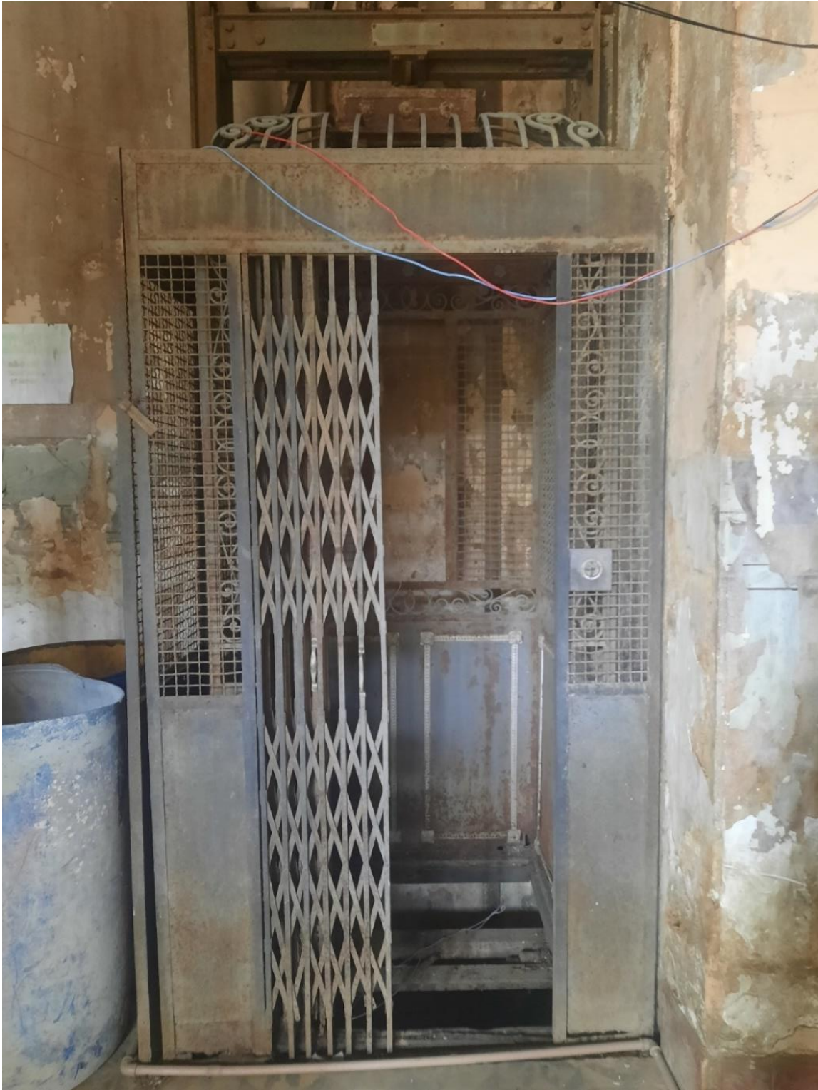
Figura 18 - elevador 1º pavimento antes do início das obras
