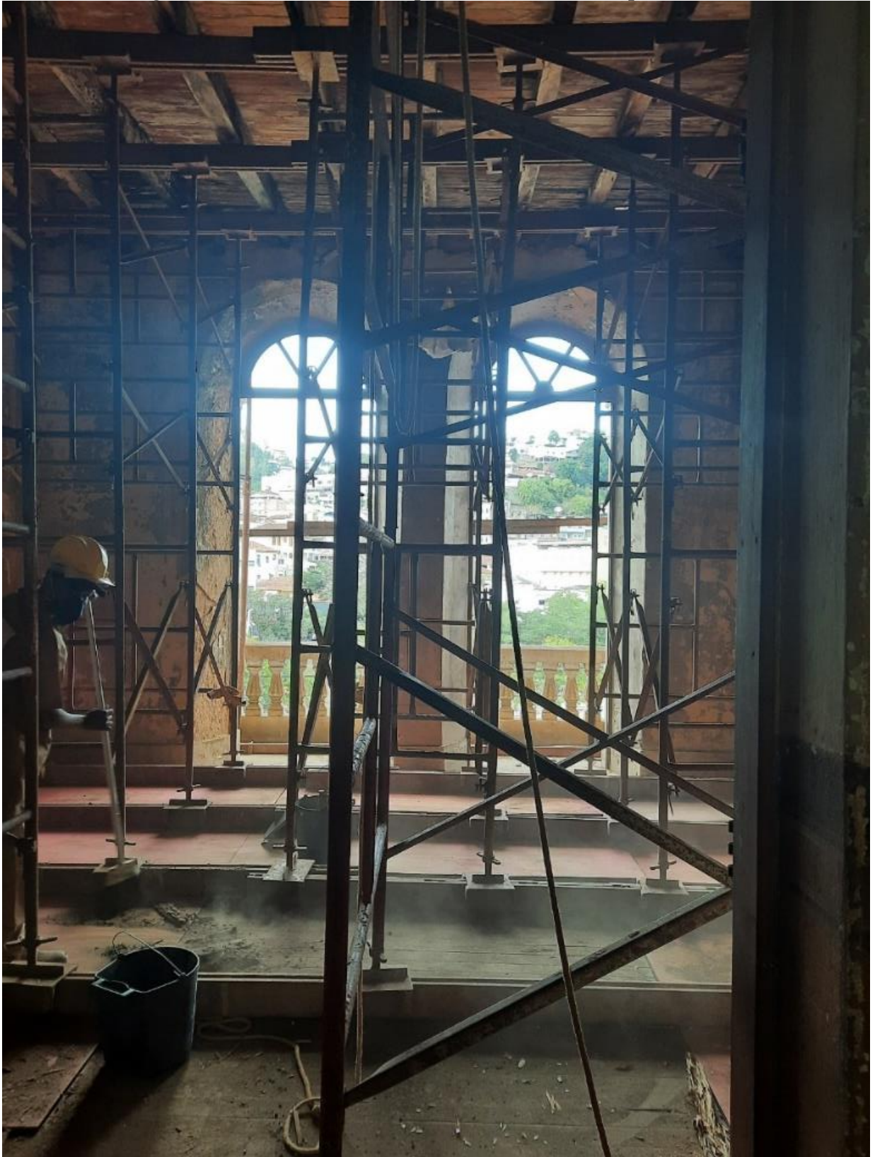
Figura 23 - interior do Hotel após início das obras 2º pavimento
