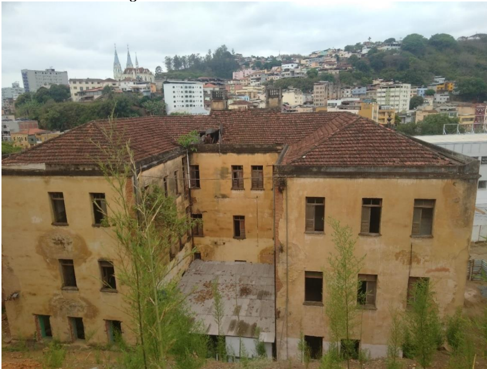
Figura 12 - Fachada Posterior antes do início das obras
