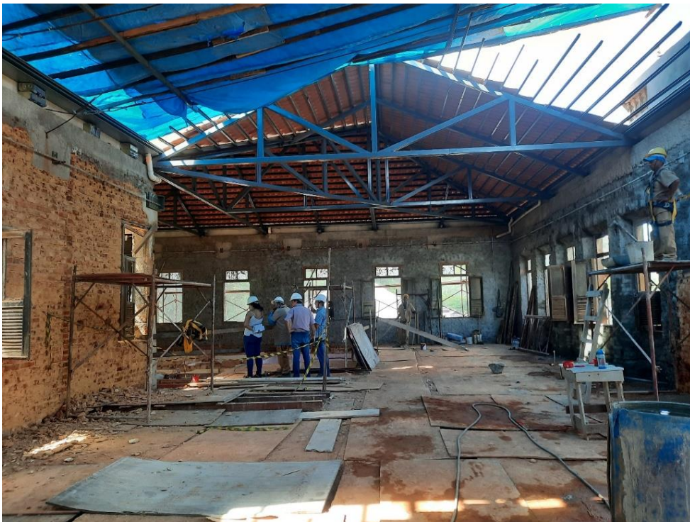
Figura 25 - interior do Hotel após início das obras 2º pavimento, demolições
