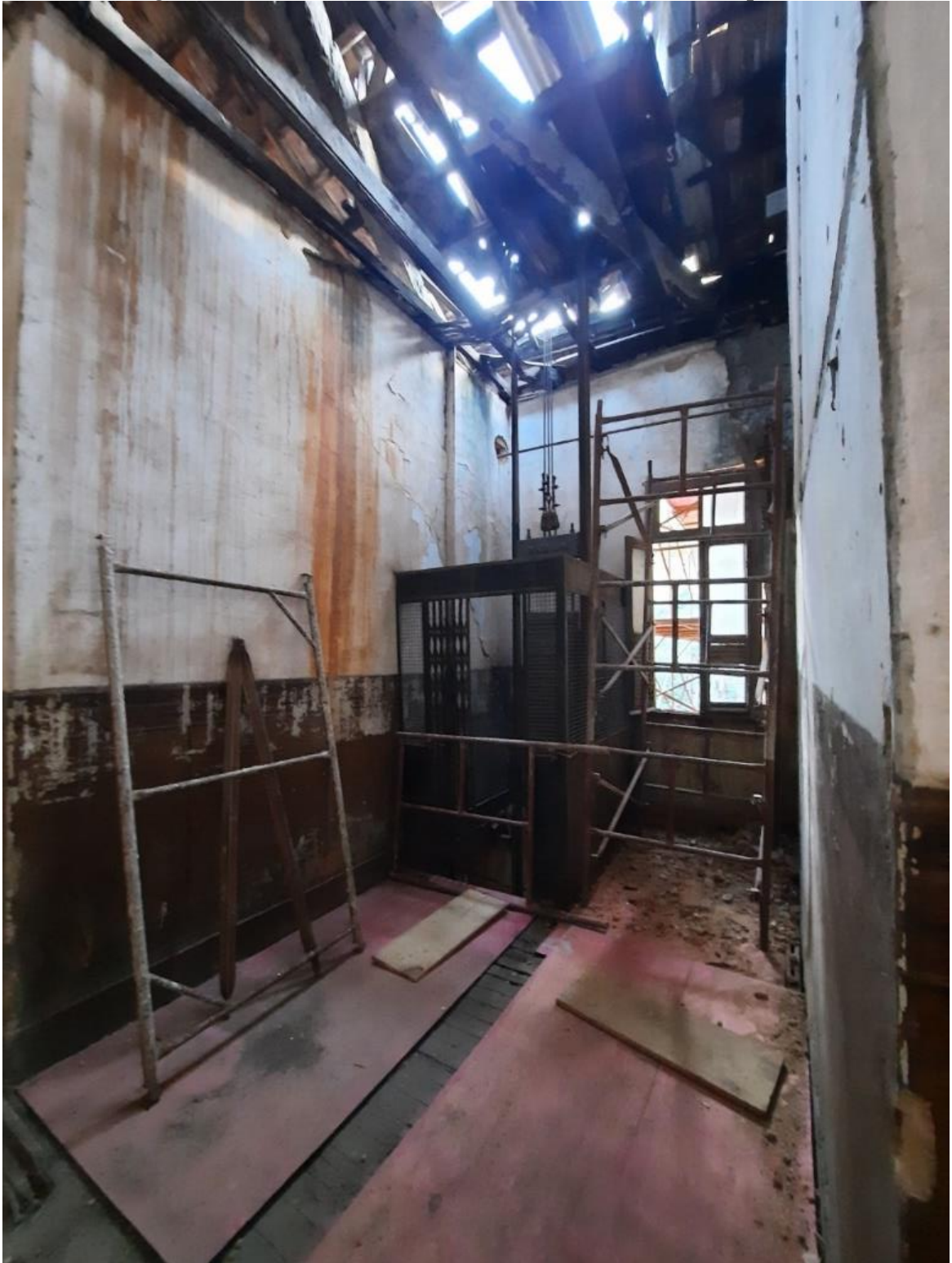
Figura 16 - Interior do Hotel antes do início das obras 2º pavimento
