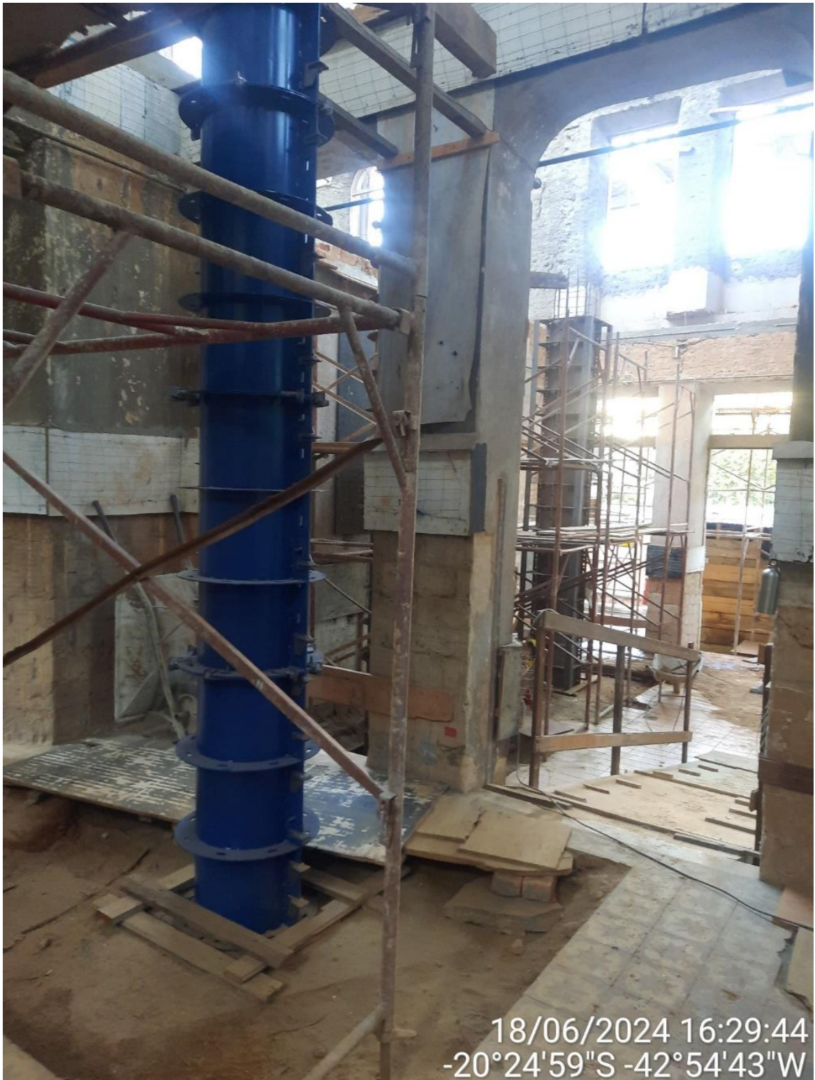
Figura 28 - Fundação 1º Pavimento
