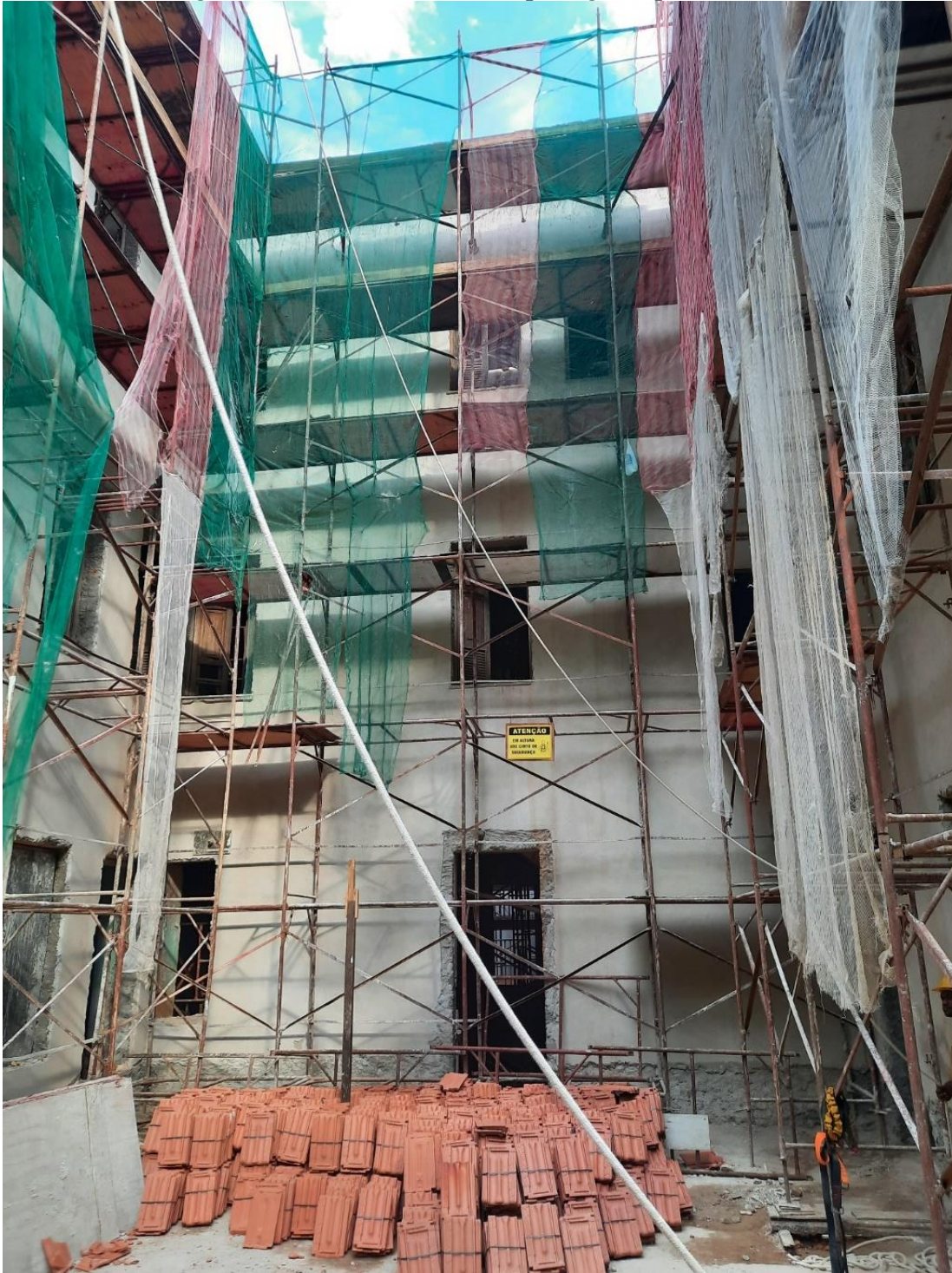
Figura 26 - Fachada Posterior protegida após início das obras
