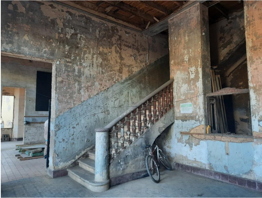
Figura 15- Interior do Hotel antes do início das obras 1º pavimento
