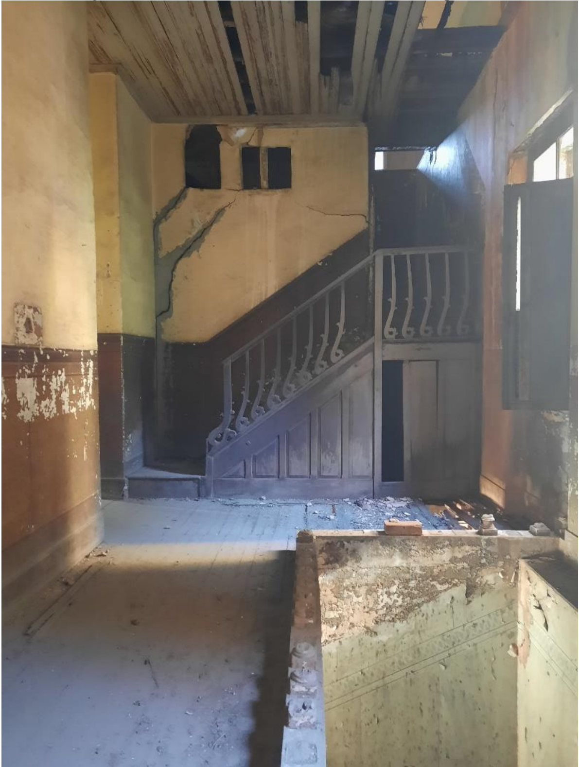
Figura 17 - Interior do Hotel antes do início das obras 2º pavimento
