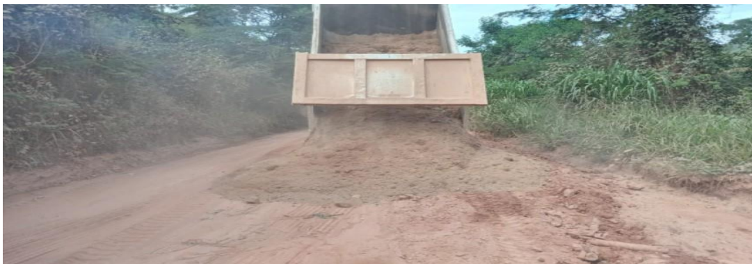
Figura 3 - Manutenções nas estradas
