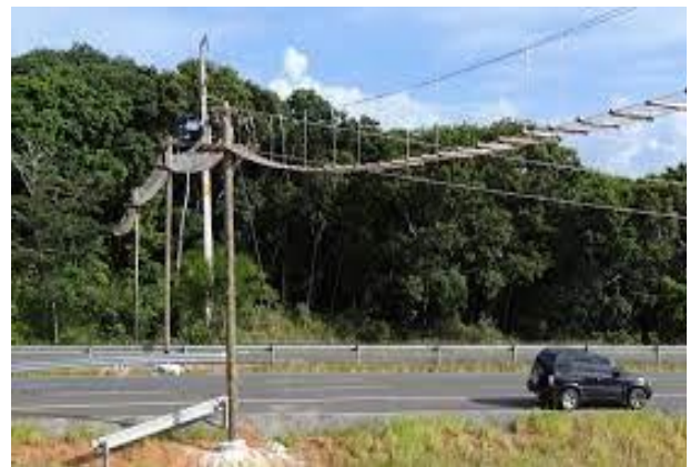
Figura 12. Esquema de passagem de fauna suspensa. Fonte: O Eco (2016).
