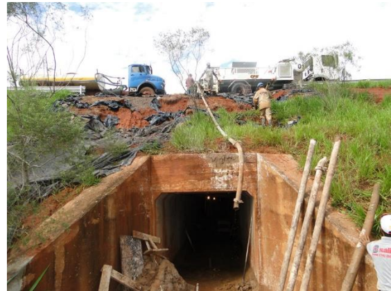
Figura 17. Construção de passagem de fauna inferior multiuso. Fonte: Google Imagens (2021).
