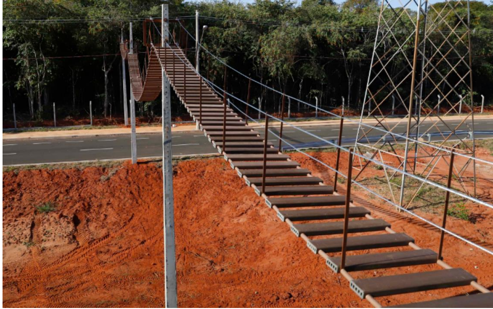
Figura 13. Passagem de fauna suspensa em construção. Fonte: O Eco (2016).
