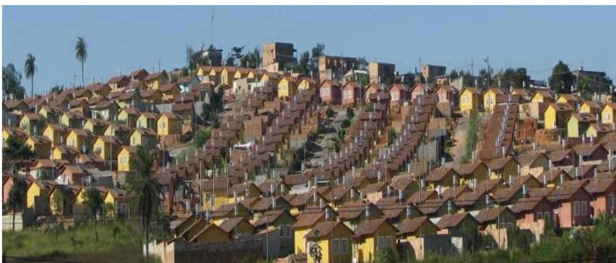
Figura 13 – Conjunto Dicalino Cabral com equipamentos de aquecedores solares de água Fonte: Prefeitura Municipal de Betim, 2013.
