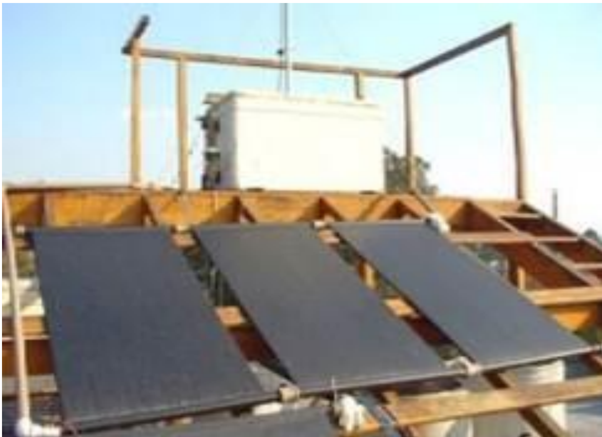
Figura 15 – Detalhe das instalações de um ASBC em residência Fonte: Sociedade do Sol, 2016.
