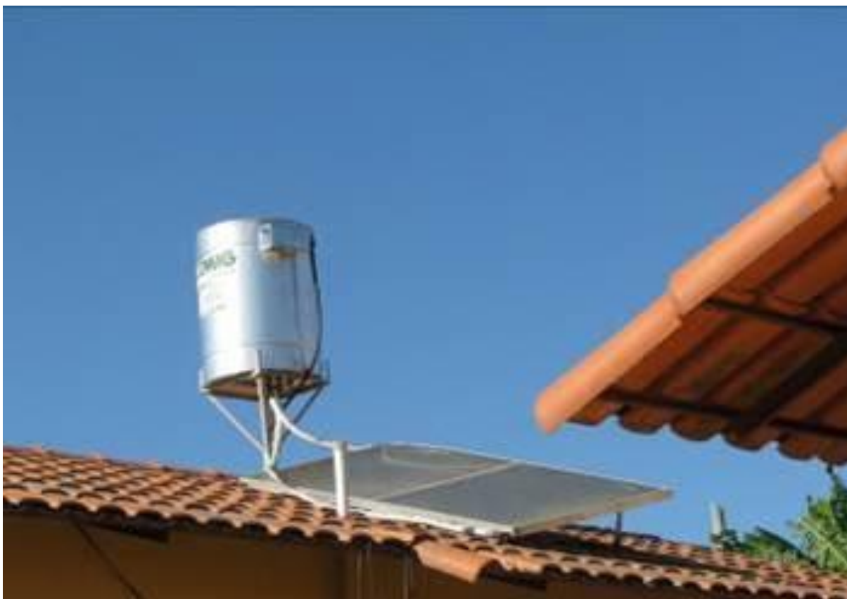
Figura 14 – Detalhe de uma residência de baixa renda (conjunto residencial) com aquecedor solar de água
