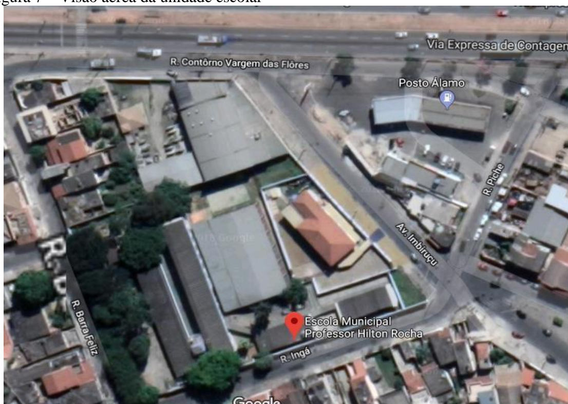
Figura 7 – Visão aérea da unidade escolar
