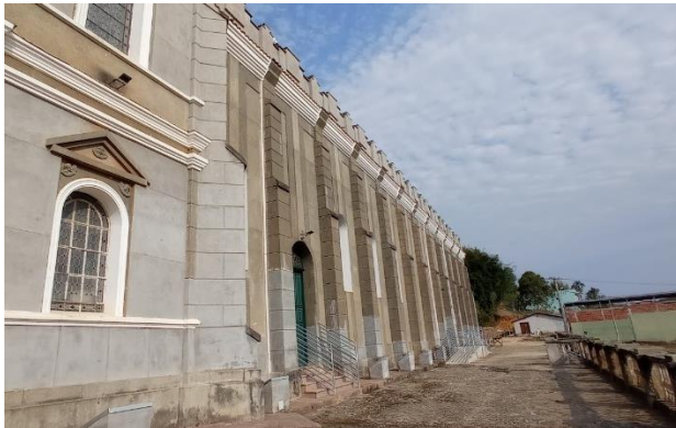
Figura 27 - Colunas estruturais, vista externa
