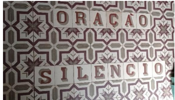
Figura 22 - Alguns ladrilhos hidráulicos presentes na atual Matriz
