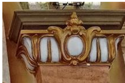
Figura 38 - Capitel existente na Matriz, o qual possui estilo próprio
