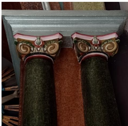
Figura 34 - Capitéis de Ordem Jônica existentes nestes pórticos da Matriz
