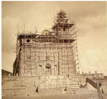
Figura 21 - Construção da atual Matriz com a torre da epístola erguida primeiro
