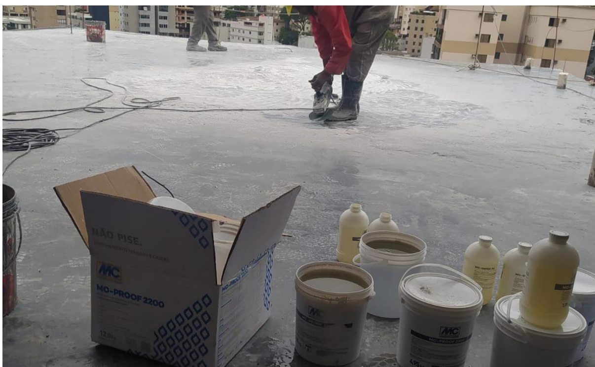
Figura 17 – Impermeabilização com membrana de poliuretano.
