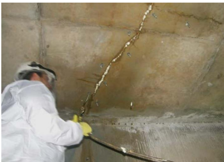
Figura 10 - Ponto de aplicação de injeção pressurizada.
