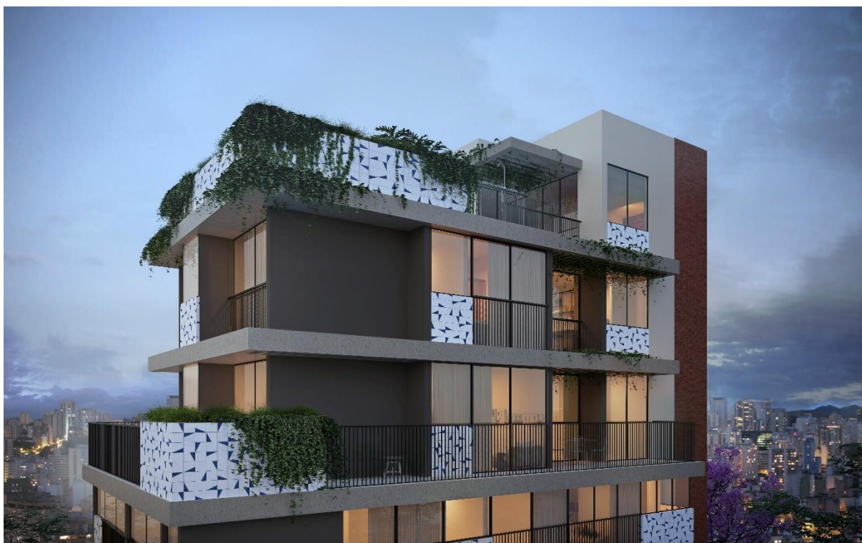
Figura 13 – Fachada posterior e lateral esquerda da edificação.
