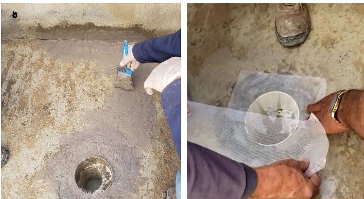
Figura 18 – Pontos críticos da impermeabilização.
