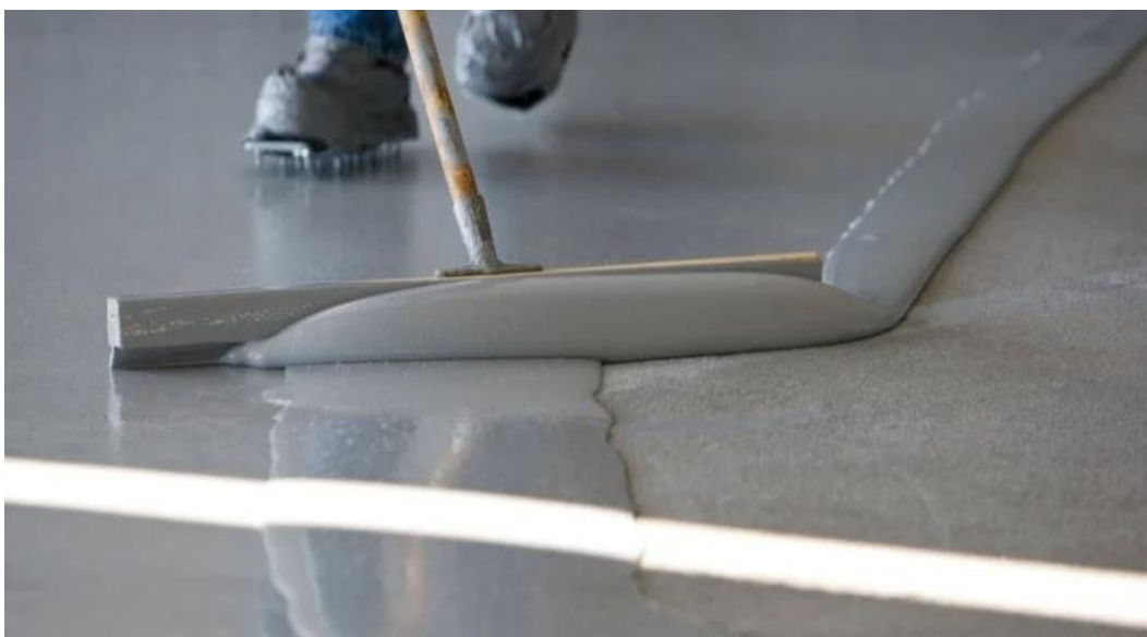
Figura 5 - Impermeabilização com Membrana de Poliuretano.
