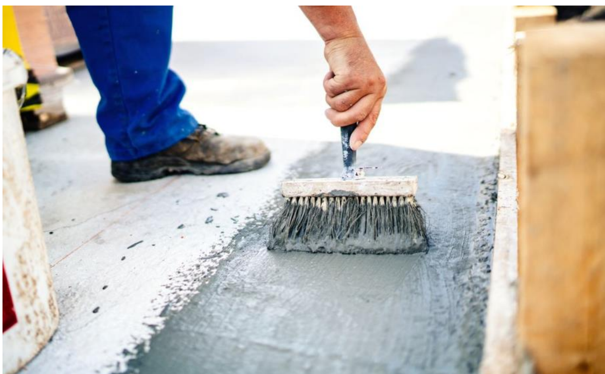
Figura 4 - Impermeabilização com argamassa polimérica.
