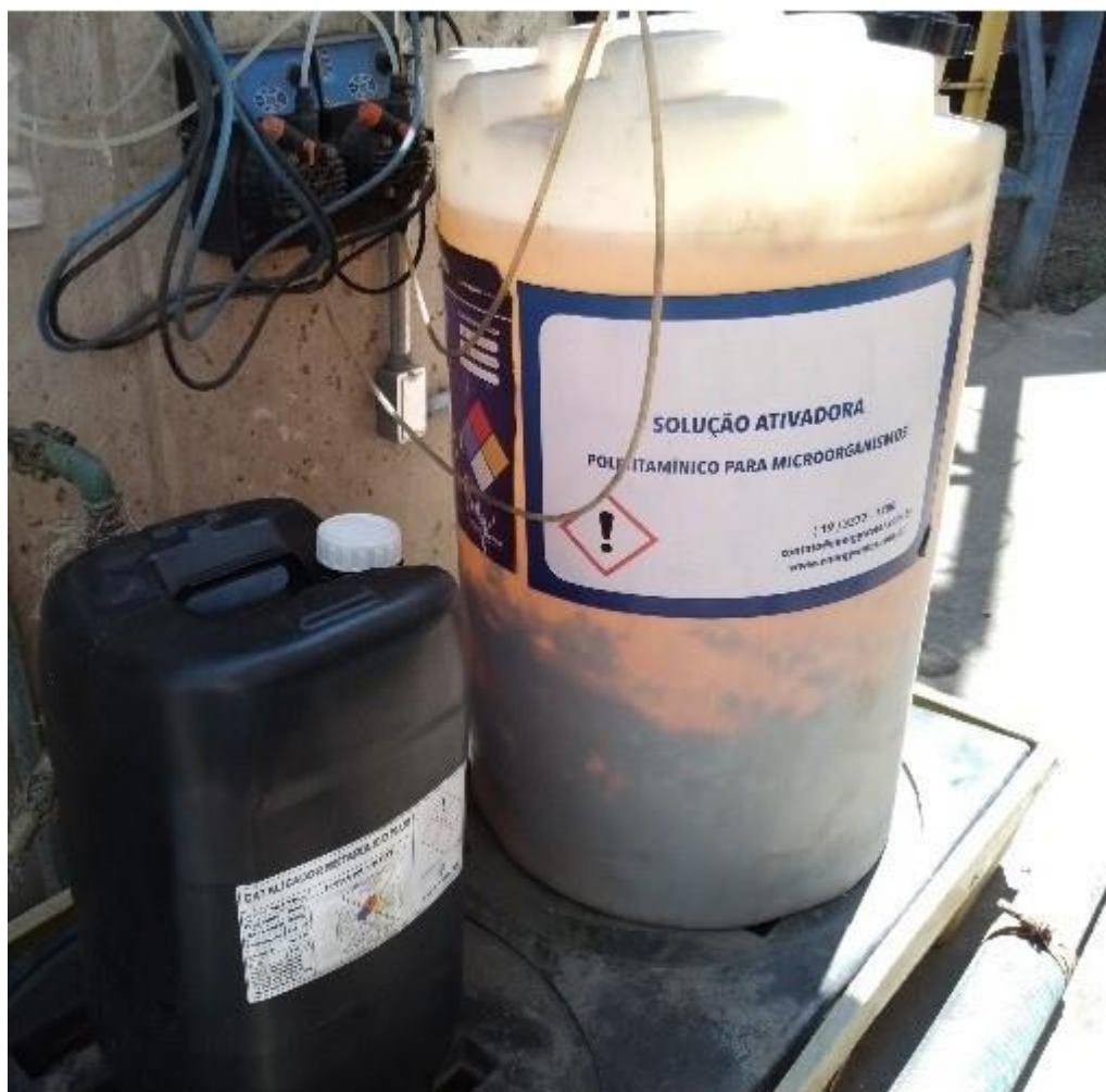
Figura 21 – Sistema de dosagem do catalisador metabólico
