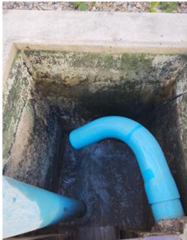
Figura 17 – Caixa de passagem do efluente tratado
