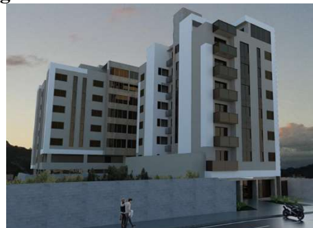
Figura 7 - Edifício Torres da Matriz
