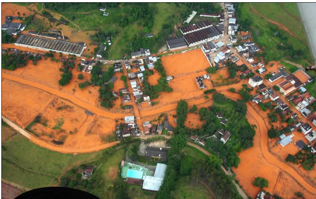
Figura 1 - Rompimento da barragem Cataguases em Mirai (2007)
