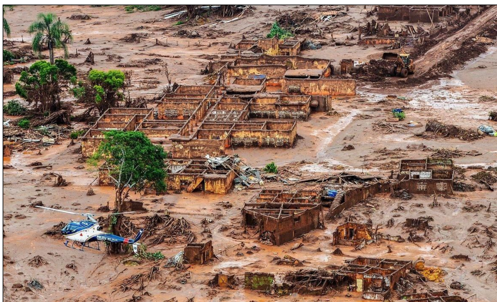
Figura 4 - Rompimento da barragem da Mina Córrego do Feijão, Brumadinho (2019)
