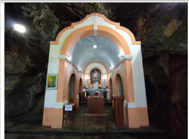
Foto 06: Fachada frontal: capela.
