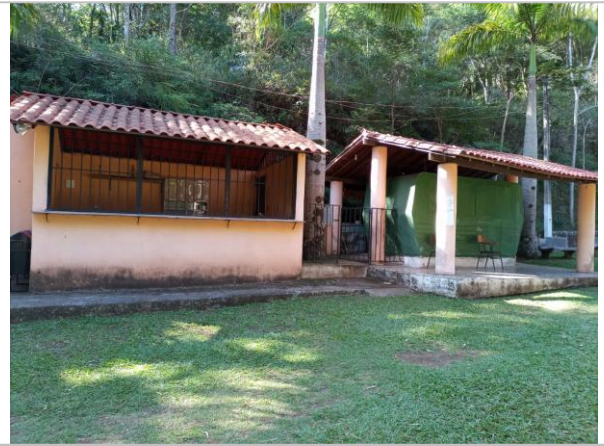
Foto 42: Área externa: vista de edificação de apoio.
