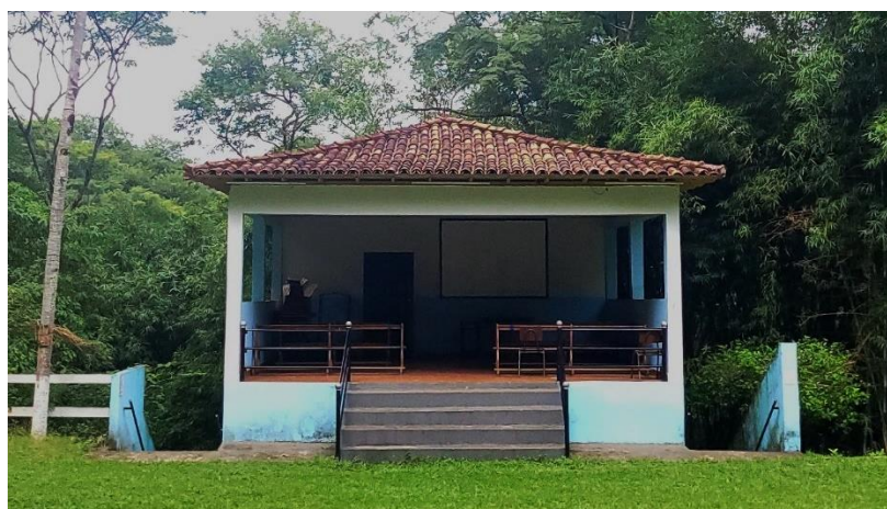
Figura 15 - Vista do palco e das escadas que dão acesso aos banheiros
