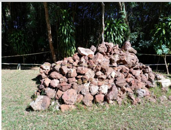
Foto 43: Área externa: pedras retiradas da edificação de apoio demolida (casa de guarda de ex-votos).
