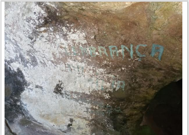
Foto 26: Vandalismo na pedra da Gruta: pixação.
