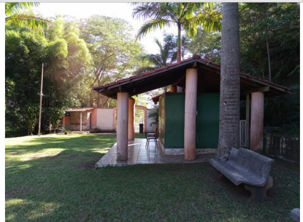
Foto 40: Área externa: vista de edificação de apoio (lanchonete).
