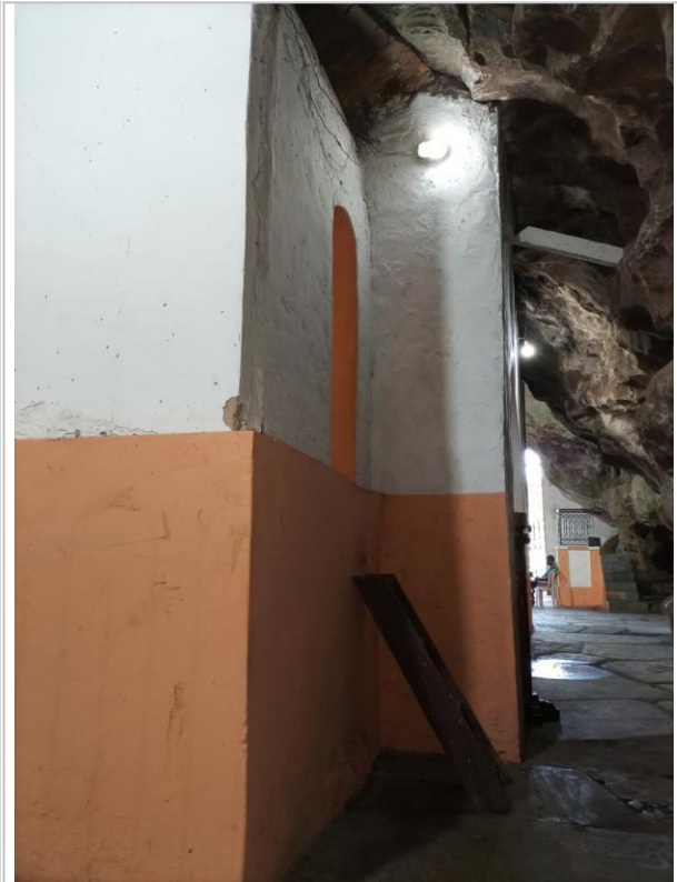
Foto 14: Capela: fachada lateral direita.
