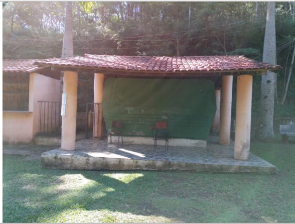
Foto 41: Edificação de apoio: vista frontal da lanchonete.
