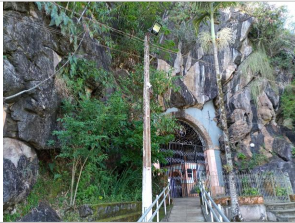
Foto 03: Acesso da Gruta da Lapa: rampa lateral e escadas frontal.
