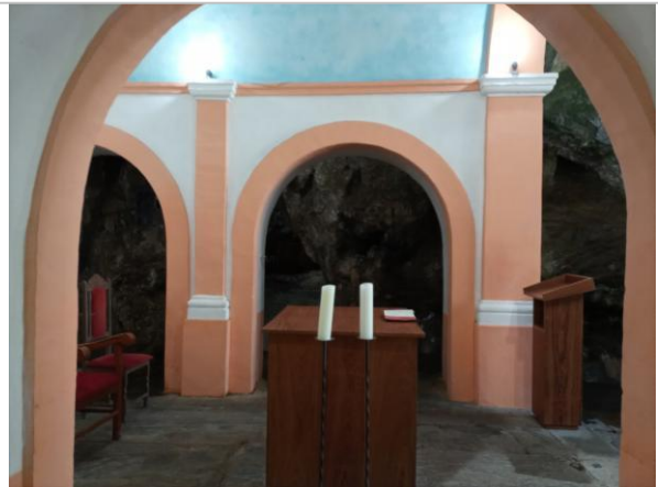
Foto 10: Capela: detalhe dos arcos estruturais laterais.
