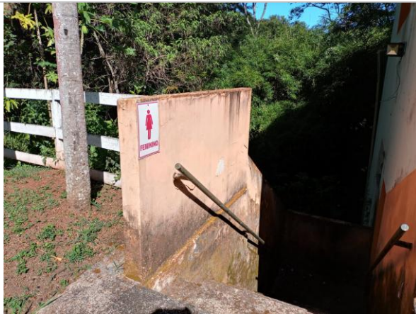
Foto 37: Edificação de apoio: acesso ao banheiro feminino.
