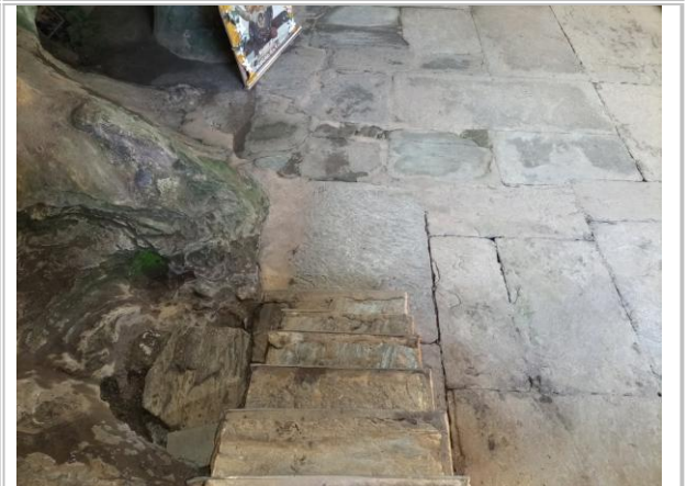
Foto 28: Detalhe do piso da Gruta em blocos de pedras regulares.
