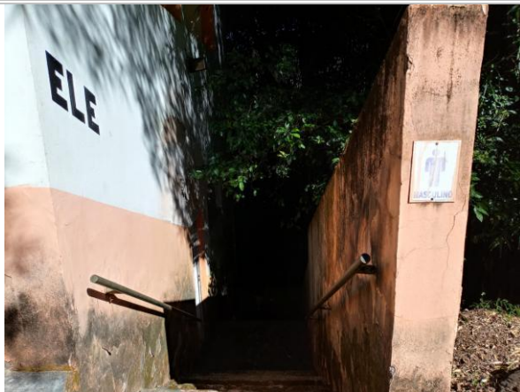
Foto 39: Edificação de apoio: acesso ao banheiro masculino.
