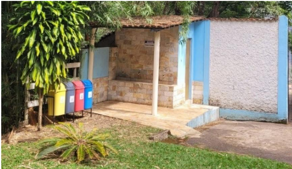
Figura 13 - Vista dos bebedouros
