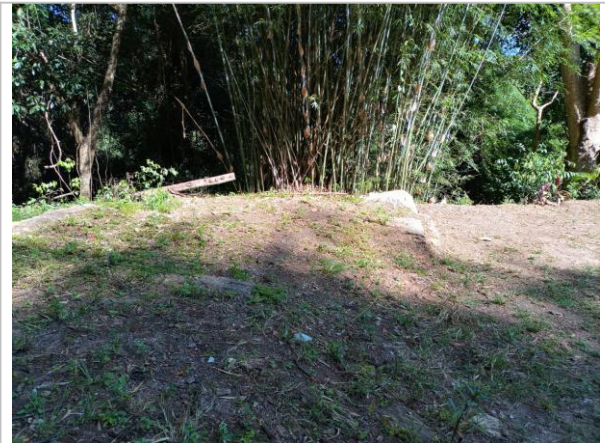
Foto 34: Área externa: remanescentes da estrutura da casa anexa de apoio para guarda dos ex-votos.
