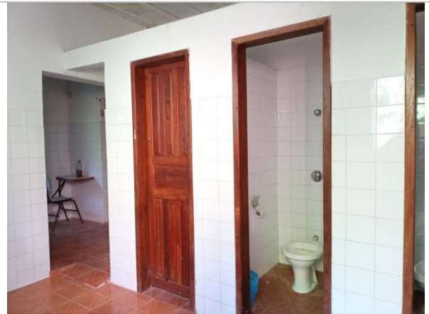
Foto 38: Edificação de apoio: banheiro feminino.
