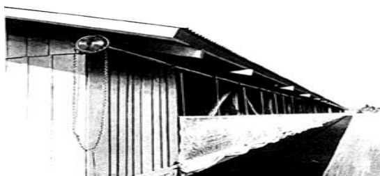
FIGURA 5.10 - Detalhe da cortina e sua movimentação.
