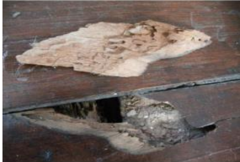
Figura 23 - Lasca de madeira solta do assoalho.
