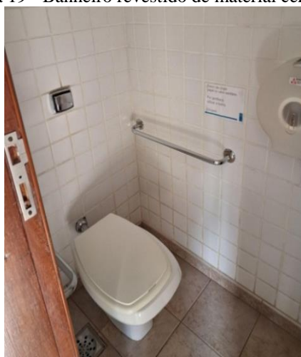
Figura 19 - Banheiro revestido de material cerâmico.
