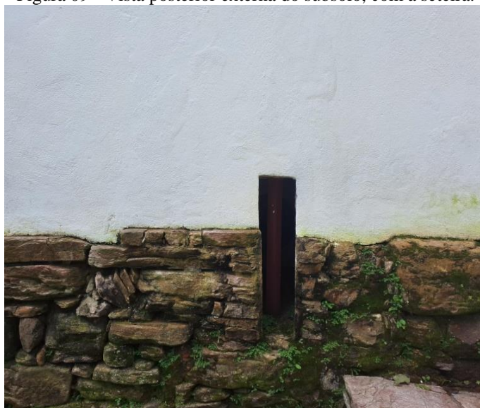
Figura 09 - Vista posterior externa do subsolo, com a seteira.
