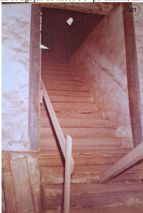
Figura 12 - Escada de ligação do térreo e 1º pavimento, antes da intervenção.
