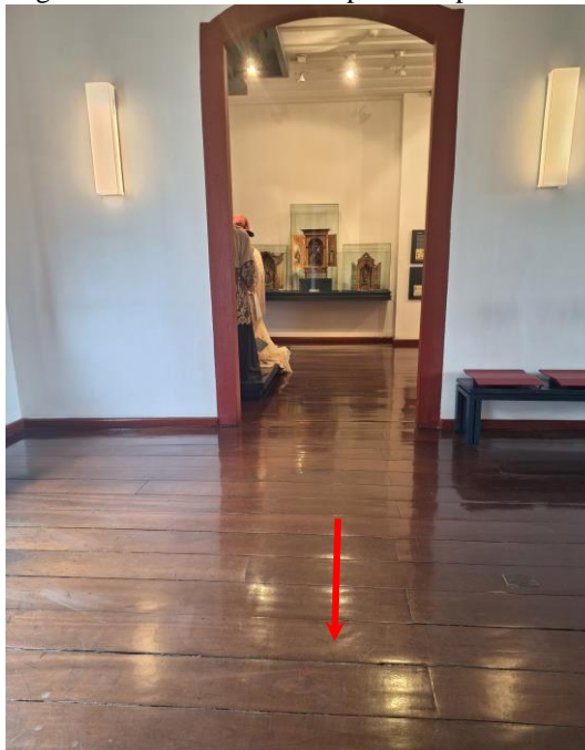
Figura 15 - Piso tabuado do primeiro pavimento.
