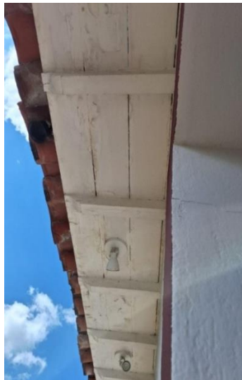
Figura 20 - Beiral encachorrado de madeira.
