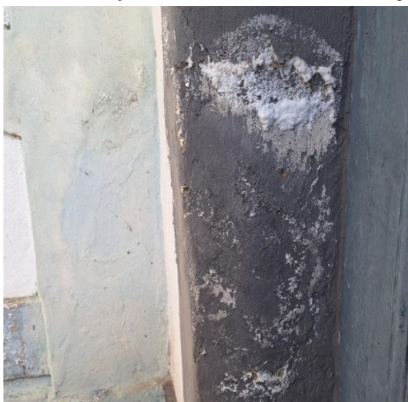
Figura 28 – Concentração de sal de nitrato na moldura em argamassa.
