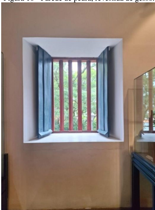
Figura 10 - Parede de pedra, revestida de gesso.
