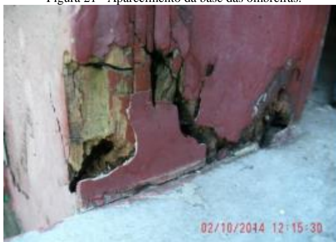
Figura 21 - Aparecimento da base das ombreiras.
