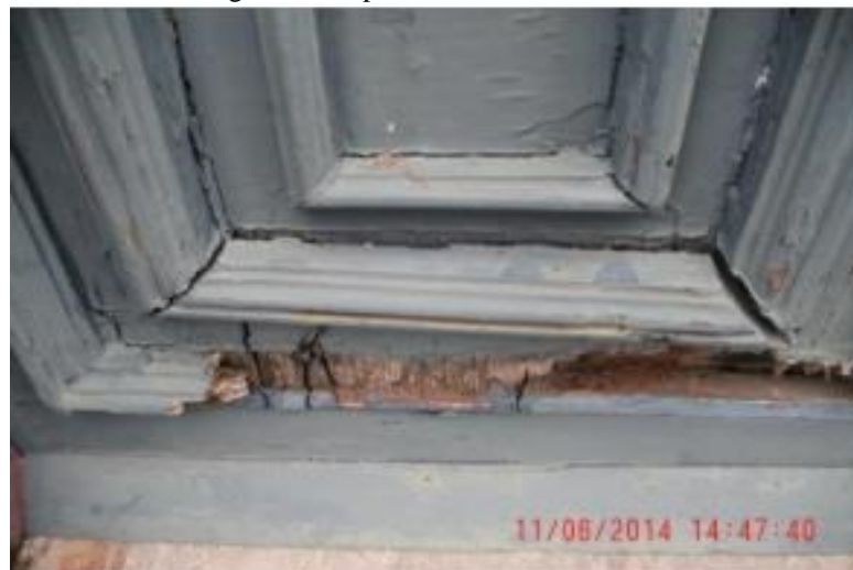
Figura 24 - Apodrecimento da moldura.
