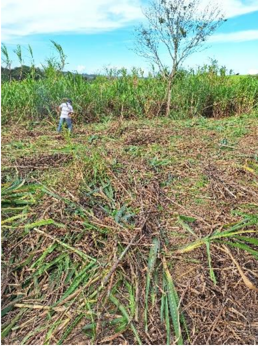
Figura 1: Limpeza da área
