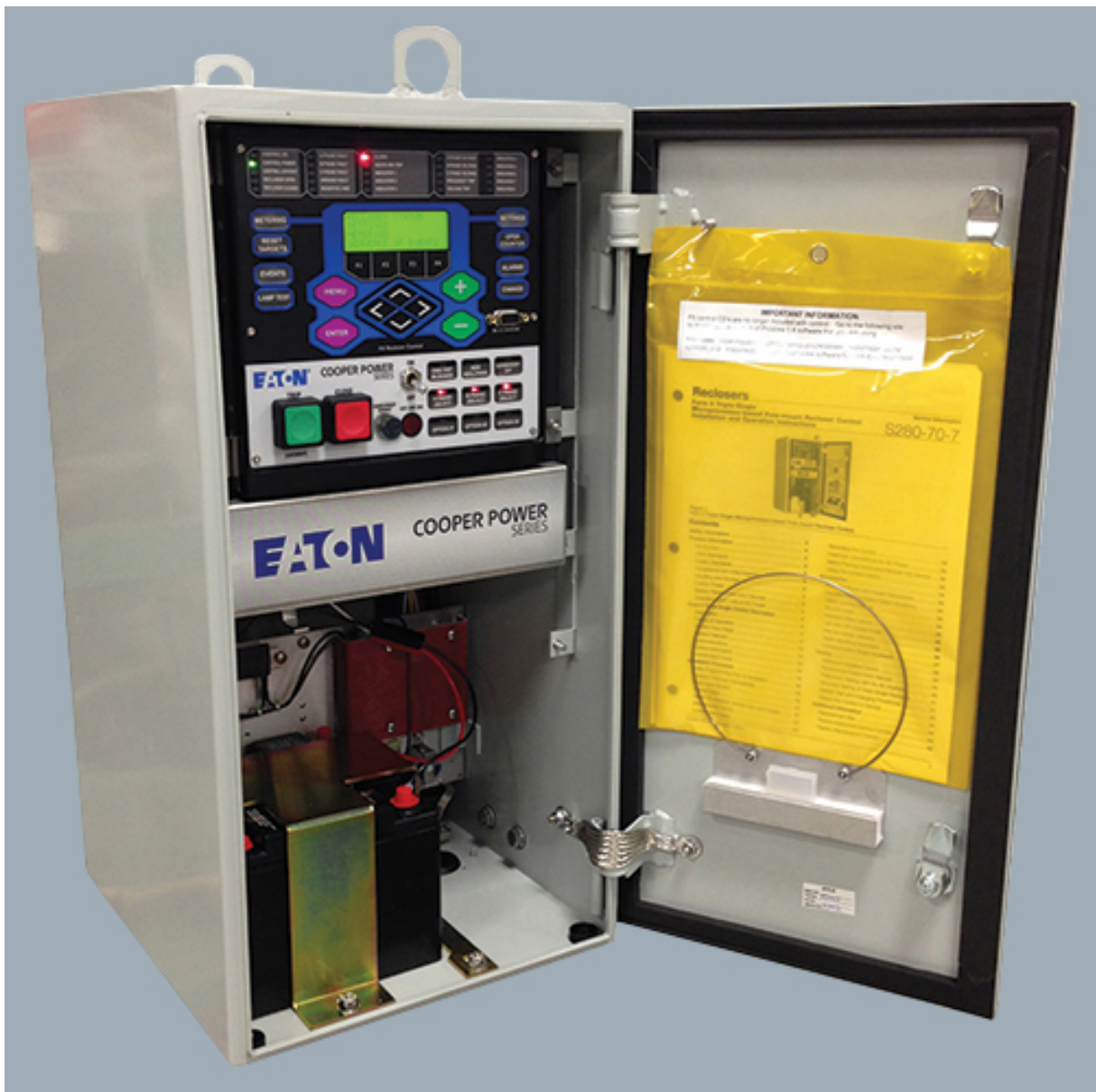
Figura 5 – Circuito de controle (caixa de comando) para religador FORM6.
