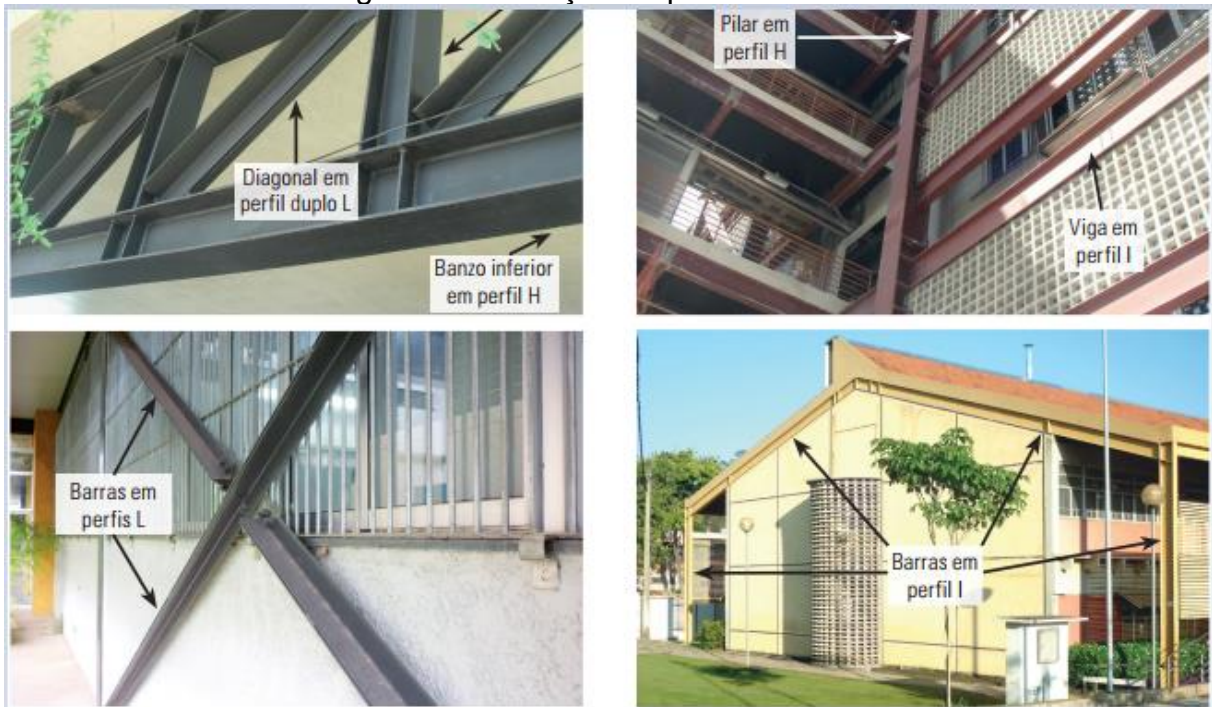
Figura 4 - Utilização de perfis metálicos
