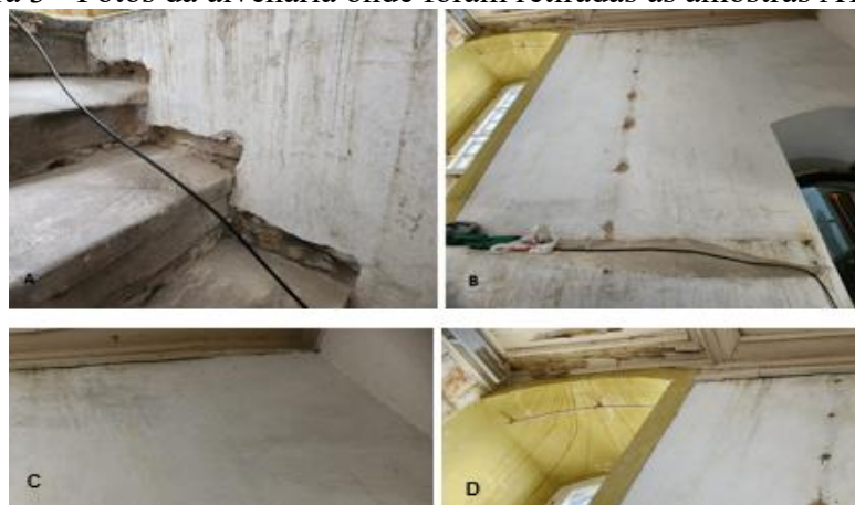
Figura 3 - Fotos da alvenaria onde foram retiradas as amostras A1 e A3.
