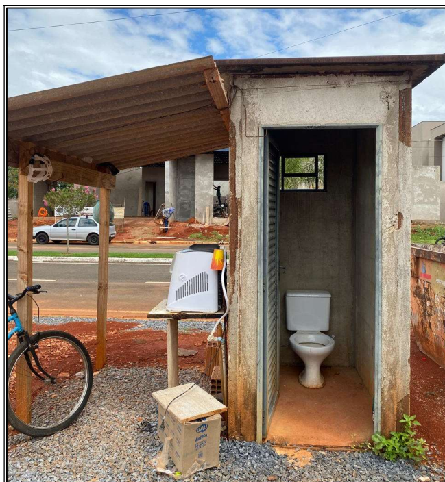
Figura 9 – Instalação sanitária (Empresa A)
