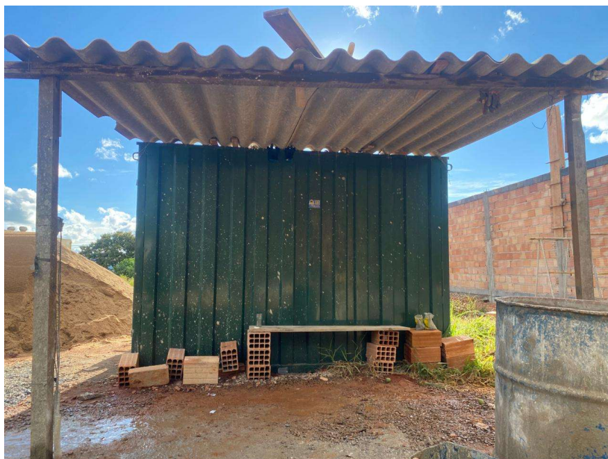
Figura 8 – Área de vivência e refeitório (Empresa B)
