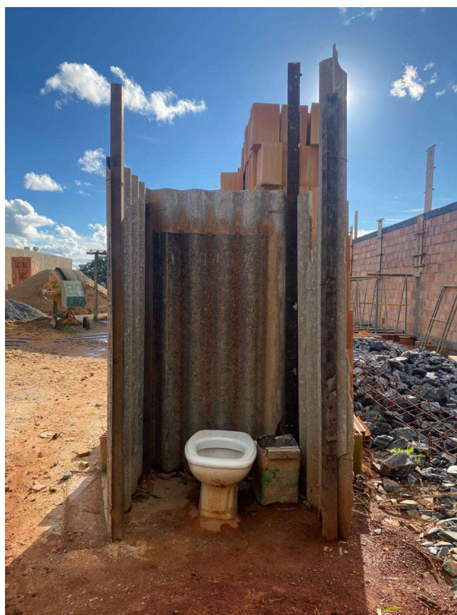
Figura 10 – Instalação sanitária (Empresa B)
