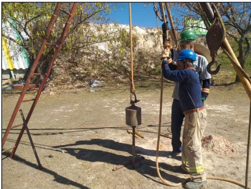
Figura 10 – realização das sondagens SPT no IFMG – Santa Luzia
