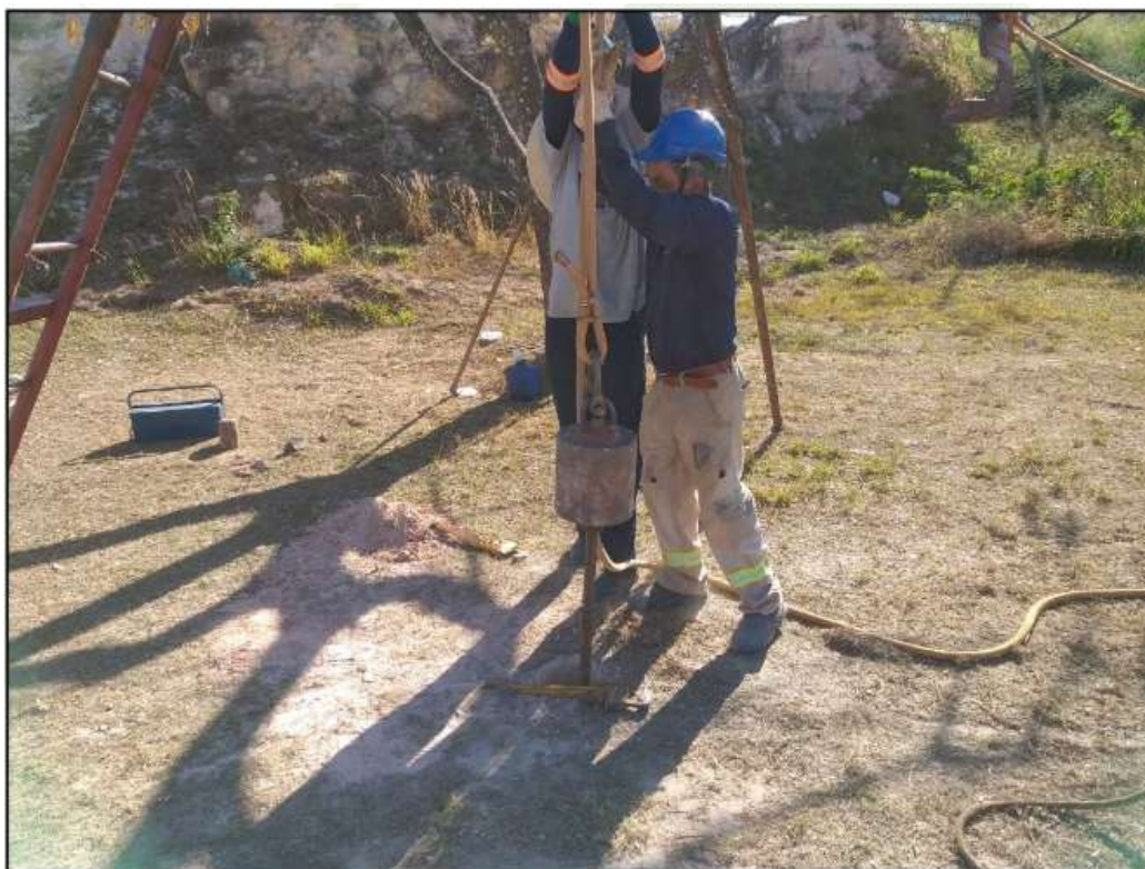
Figura 11 – realização das sondagens SPT no IFMG – Santa Luzia
