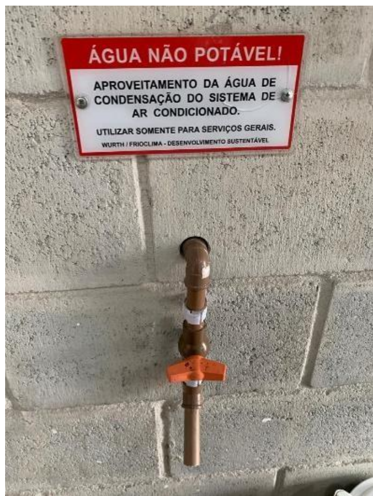
Figura 18 - Válvula esfera instalada
