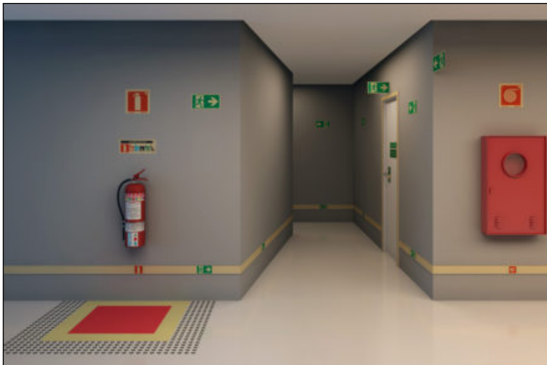
Figura 11 - Extintor de incêndio instalado em parede
