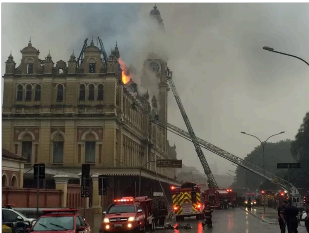
Figura 05 - Incêndio do Museu da Língua Portuguesa (2015)
