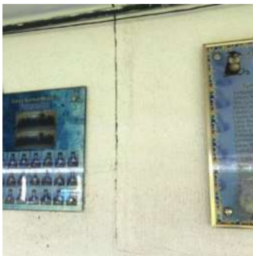
Figura 1 – Fissura Isolada
