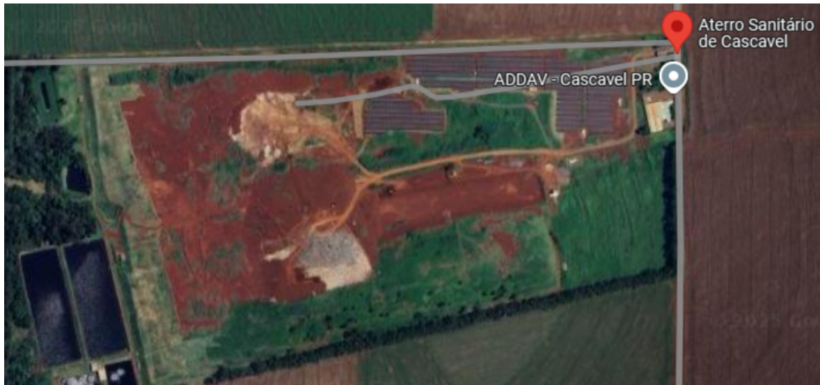
Figura 39 – Usina fotovoltaica de Cascavel sobre o aterro sanitário
