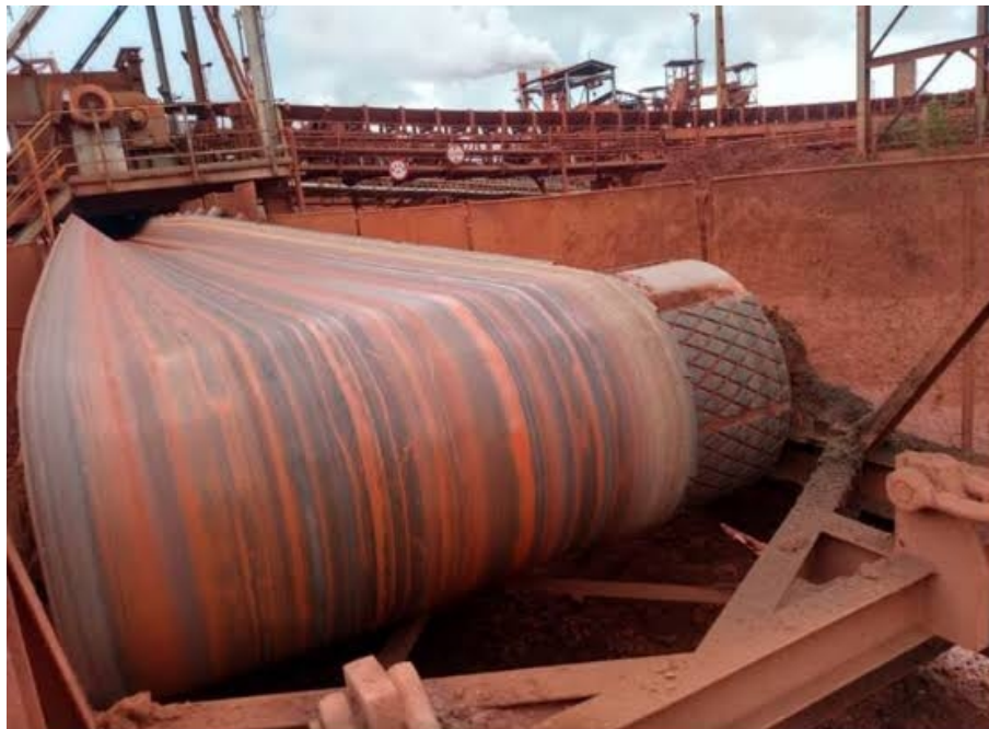
Figura 11 – Desalinhamento da correia.
