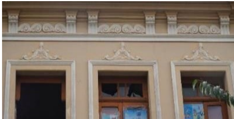
Figura 36: Detalhes da ornamentação presente na fachada frontal do Casarão dos Presentes.
