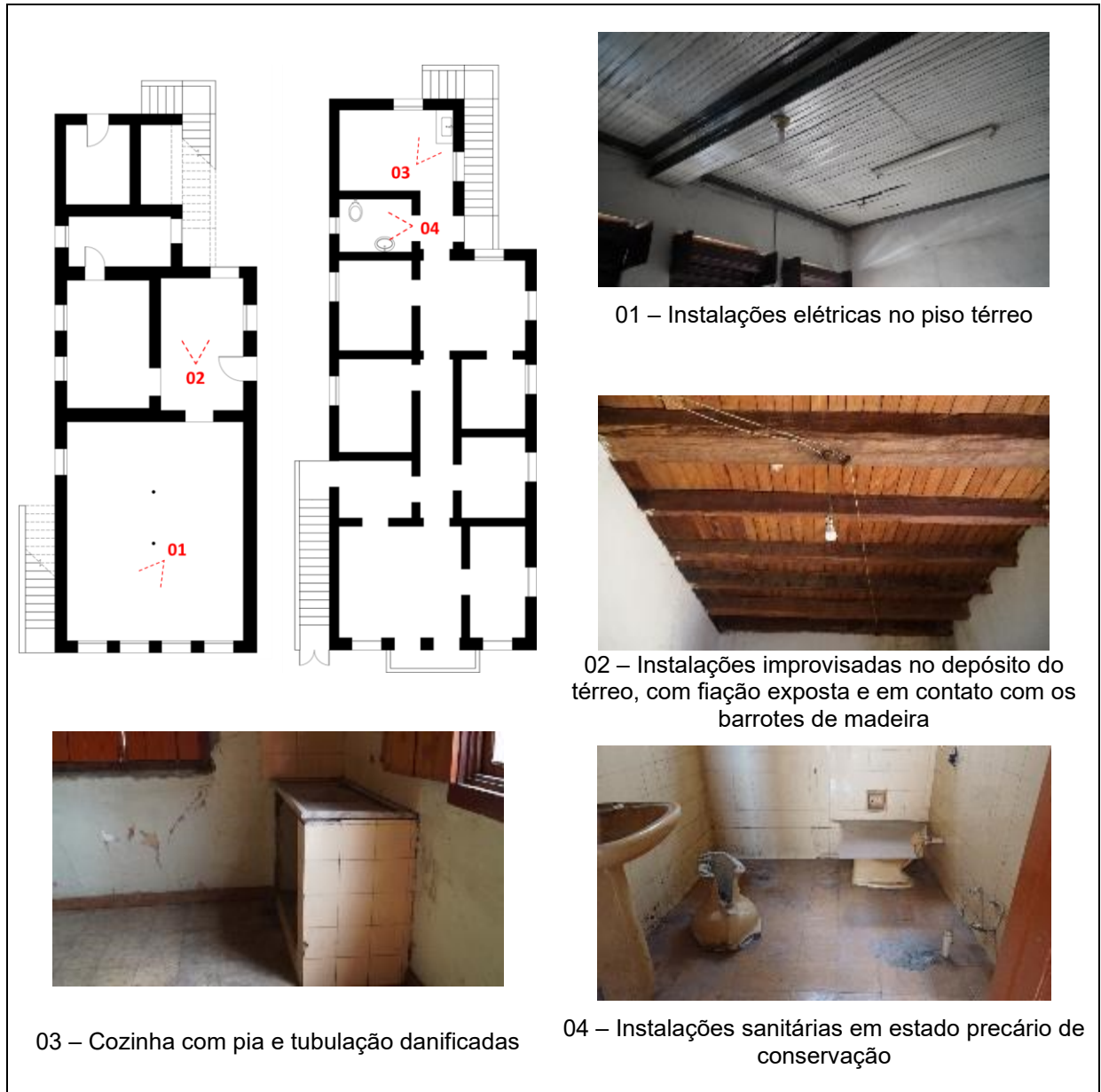
Figura 42: Danos relacionados às instalações elétricas e hidrossanitárias.
