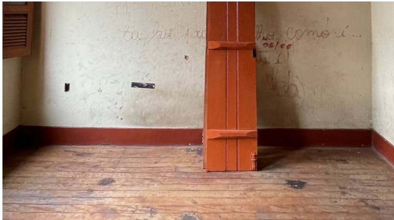
Figura 33: Detalhe para o piso em madeira no pavimento superior.
