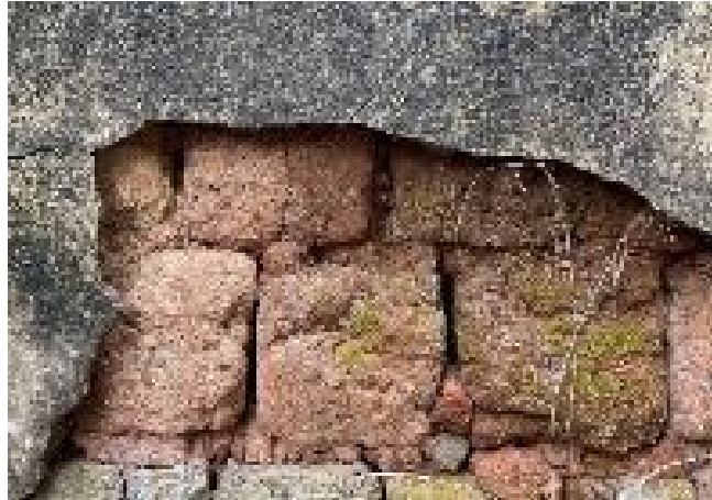
Figura 22: Muros externos erigidos com tijolos de maciços.
