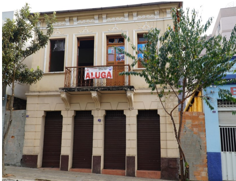
Figura 35: Fachada frontal do Casarão dos Presentes.
