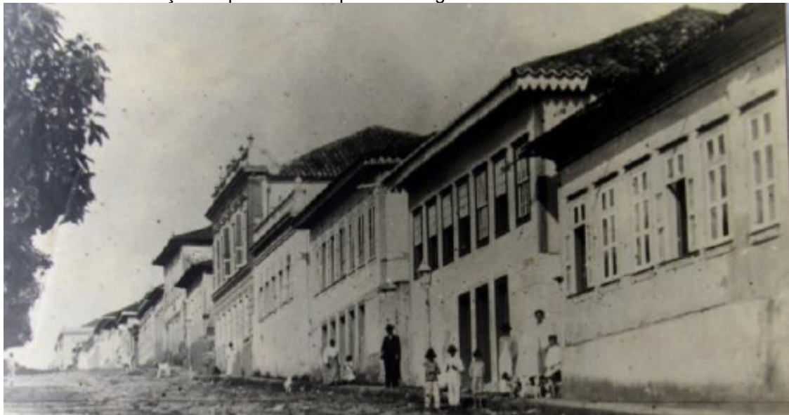
Figura 6: Avenida Rio Branco em Varginha/MG, com edificações de uso misto: térreo comercial e habitação no pavimento superior. Fotografia do início do século XX.
