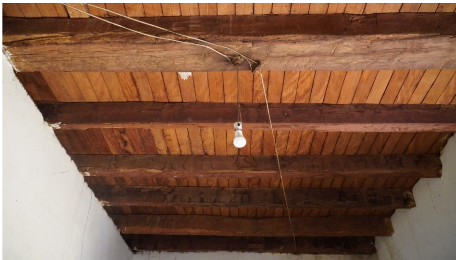
Figura 23: Barroteamento de madeira para piso em tabuado no pavimento superior.
