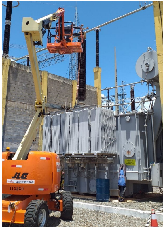
Figura 18 – Inspeção em campo no autotransformador.
