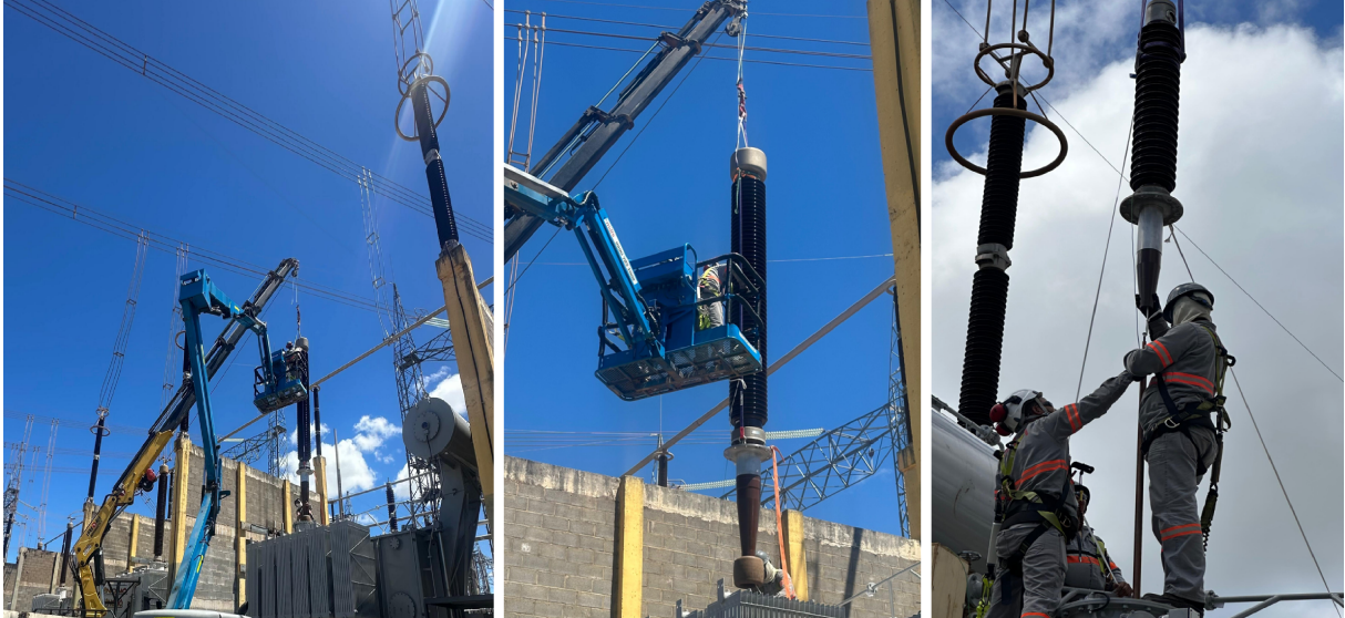
Figura 25 – Montagem do transformador em campo.
