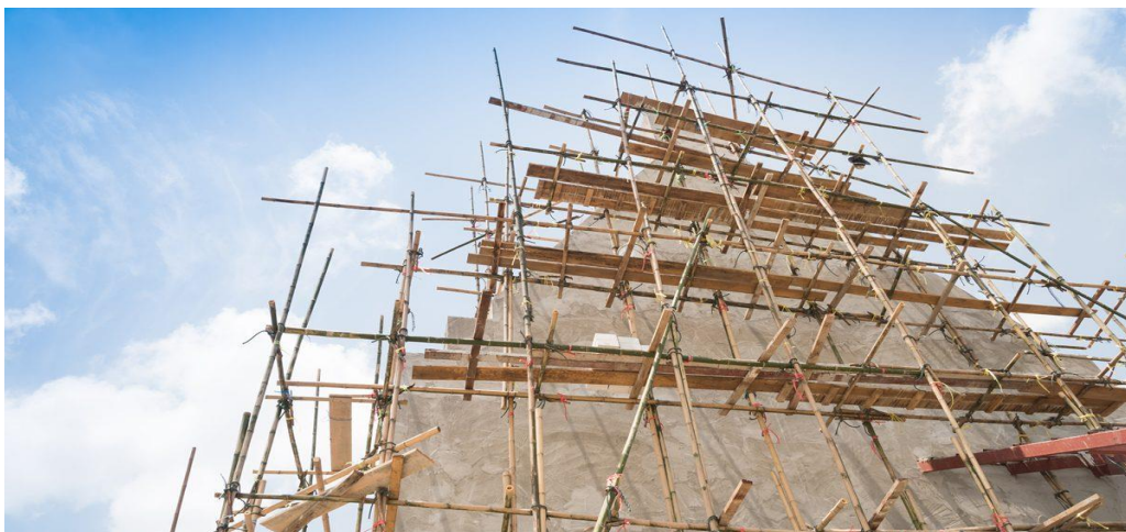
Figura 18 - Uso do bambu como andaime de assistência para construção.
