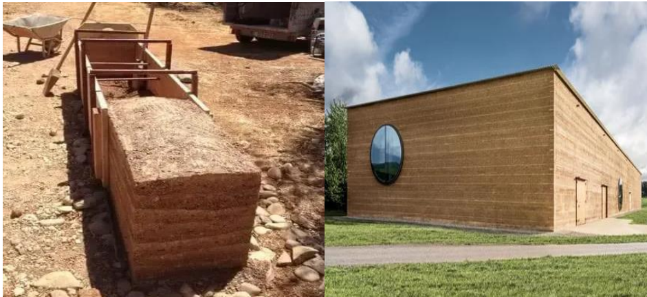
Figura 25 e 26 - Confeção de taipas de pilão e resultado final em uma residência.
