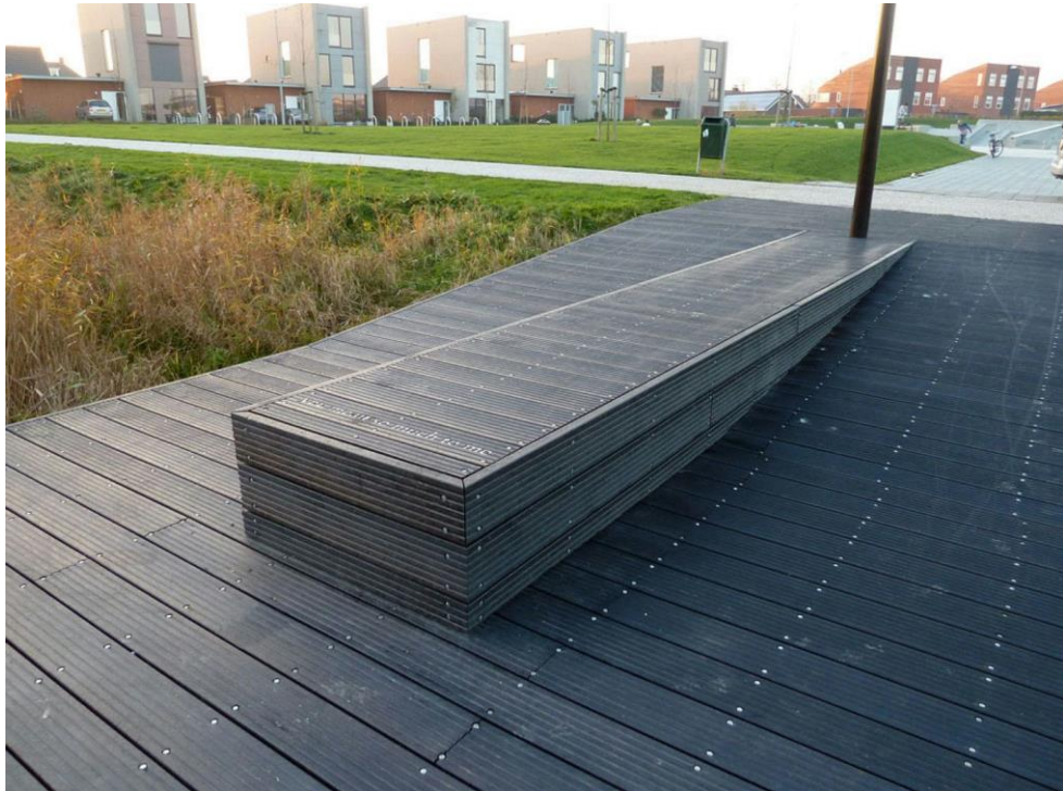
Figura 16 - Tábuas para deck feitas em plástico reciclável.
