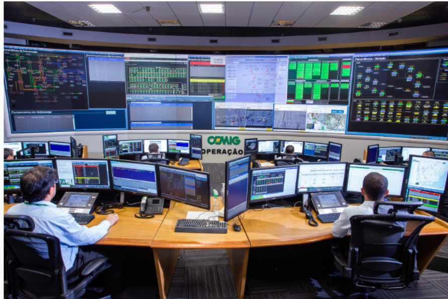
Figura 8 – Centro de Operação da Distribuição CEMIG
