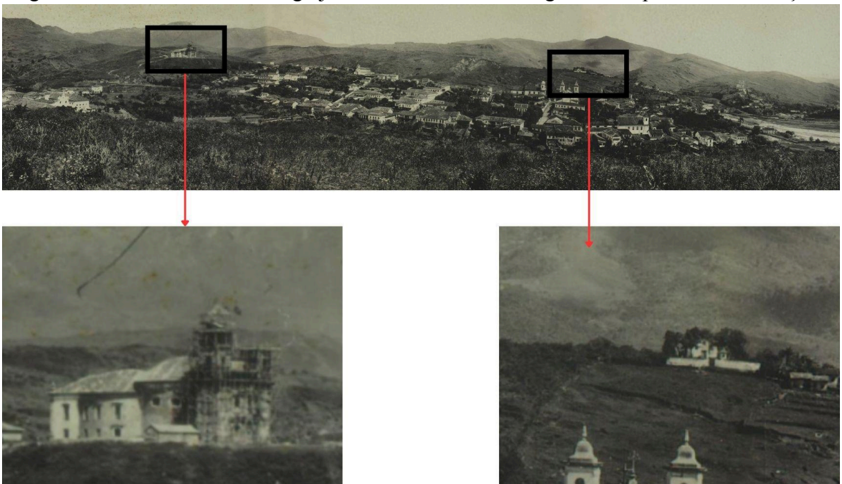
Figura 8: Detalhe das obras na igreja de São Pedro dos Clérigos e da capela de São Gonçalo
