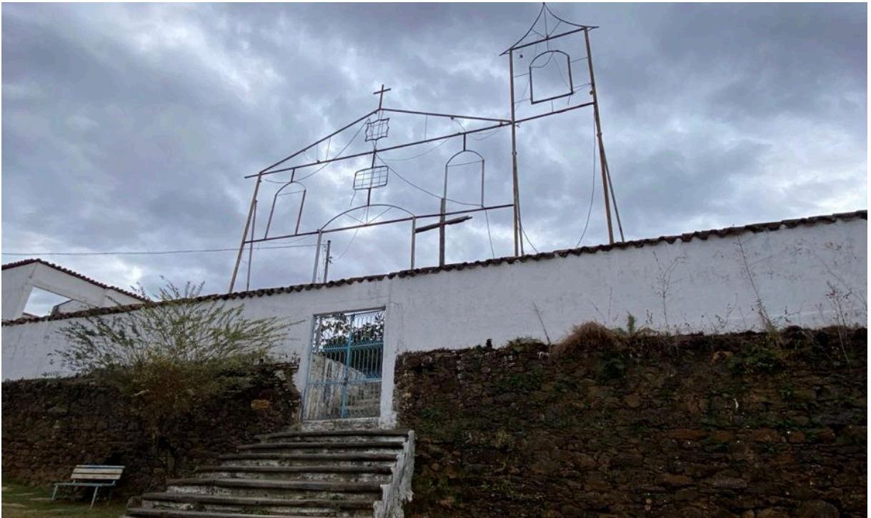
Figura 11: Muro e escadaria do cemitério de São Gonçalo.
