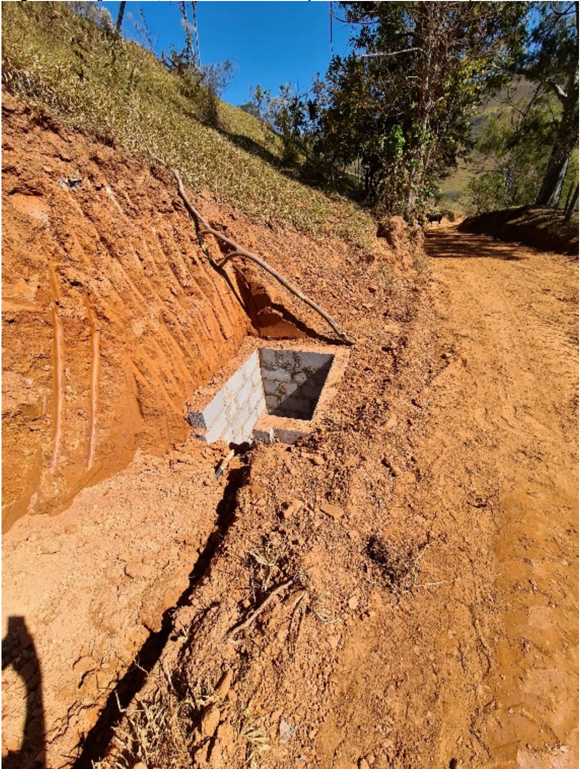
Figura 47: Imagem antes, no momento da intervenção no trecho Morro do Chapéu do Ambrósio.
