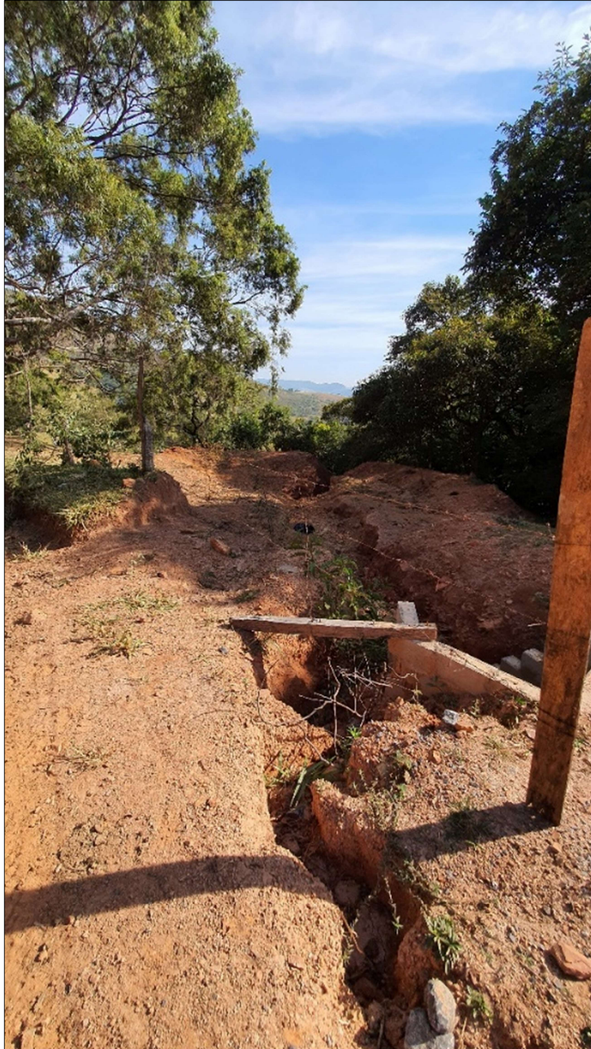
Figura 50: Imagem atual, após a intervenção, no trecho Morro do Chapéu do Ambrósio.
