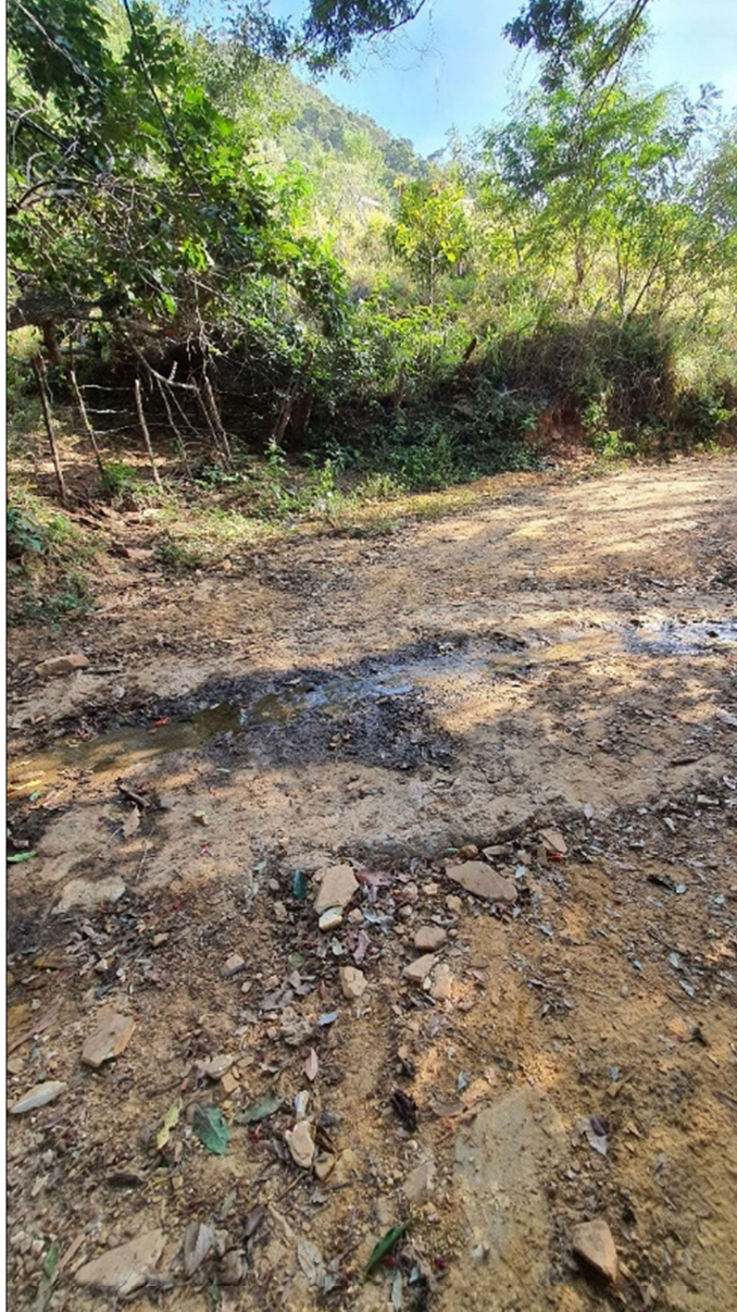
Figura 46: Imagem atual, após a intervenção, no trecho principal do Ambrósio.
