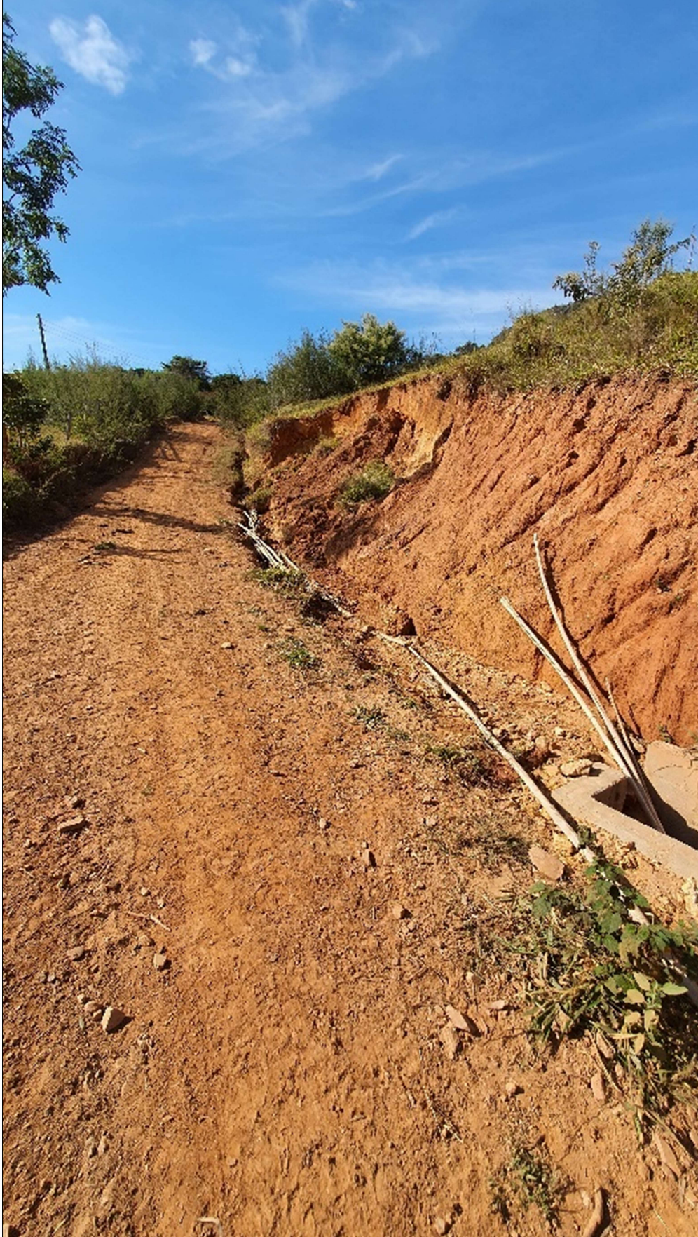
Figura 48: Imagem atual, após a intervenção, no trecho Morro do Chapéu do Ambrósio.
