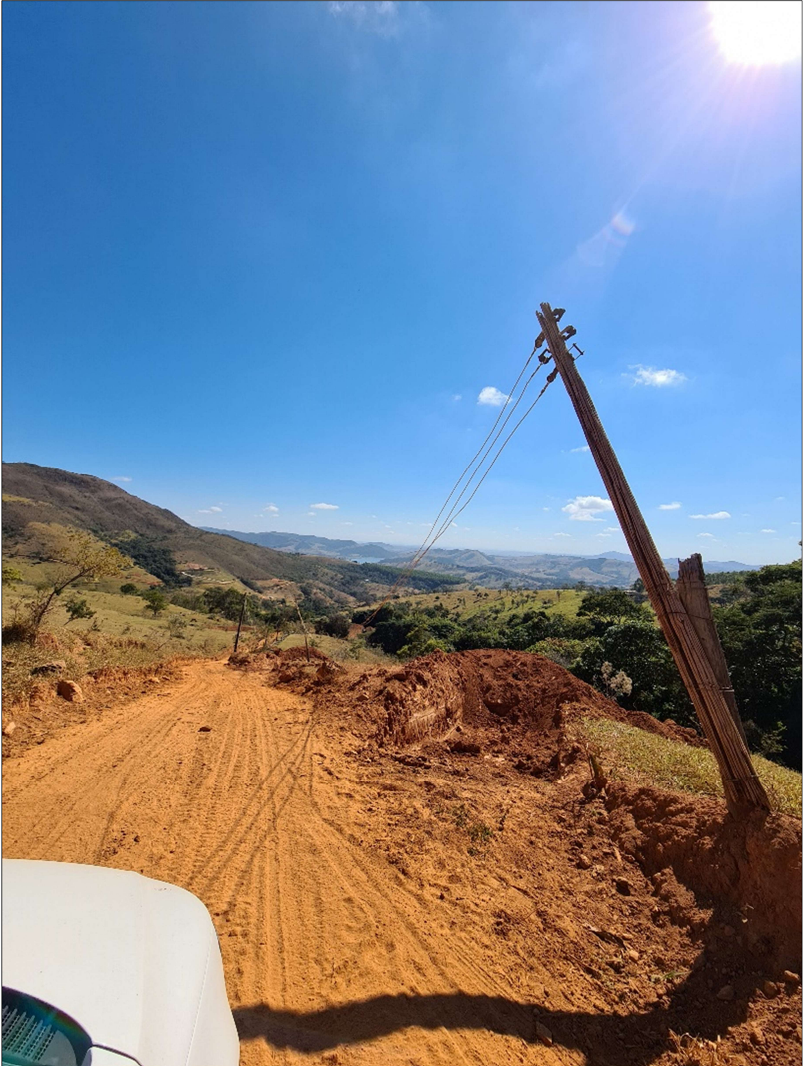
Figura 51: Imagem antes, no momento da intervenção no trecho Morro do Chapéu do Ambrósio.
