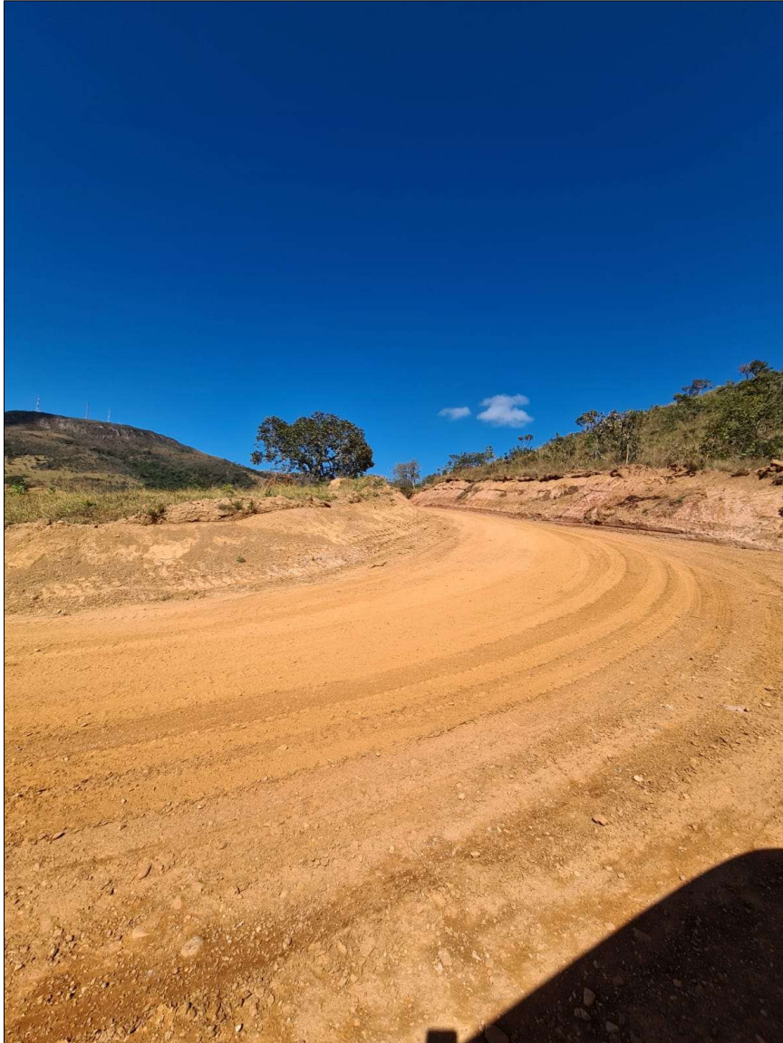
Figura 2: Trecho de estrada vicinal localizado em Ambrósio, Capitólio - MG.
