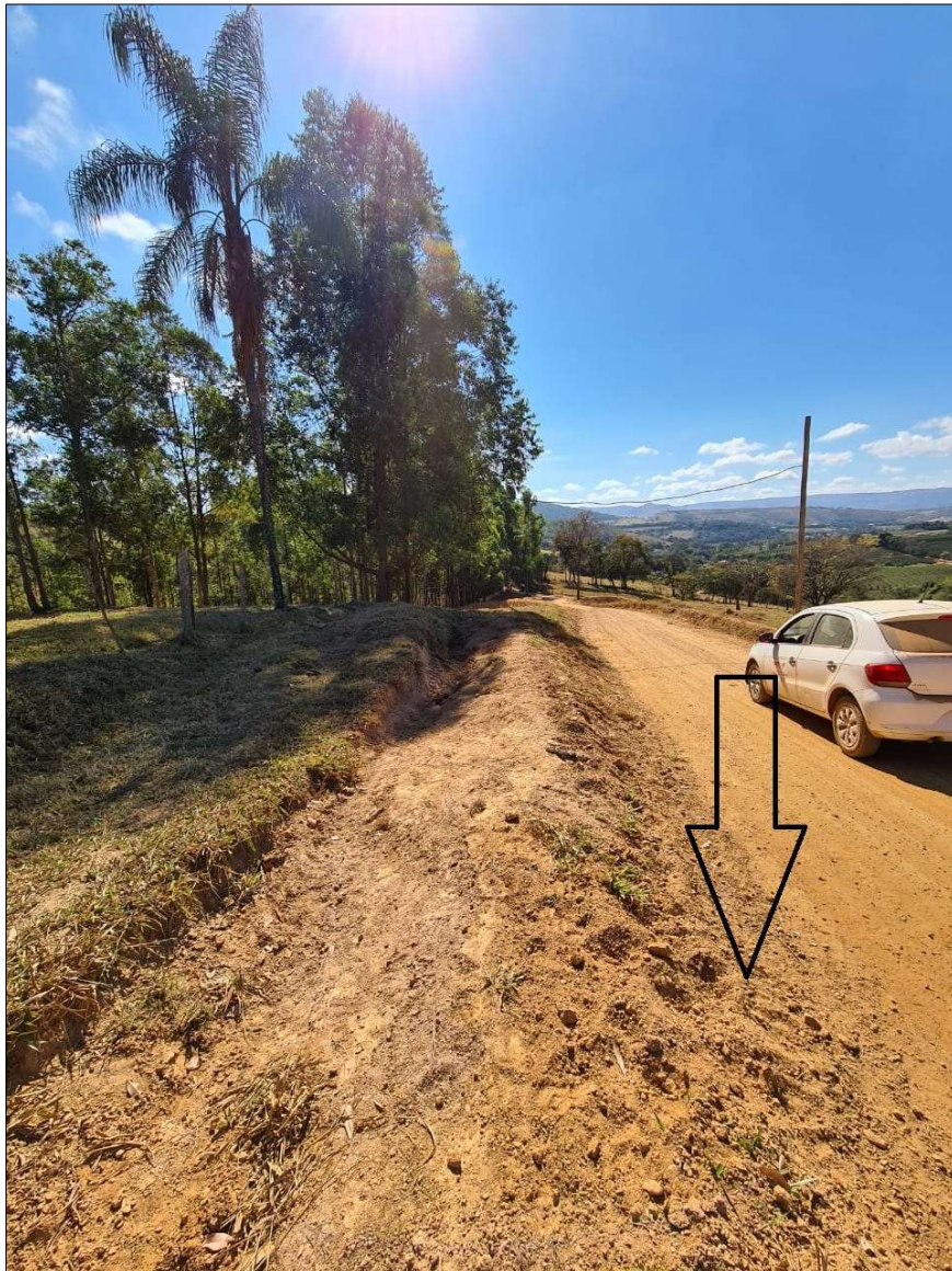
Figura 19: Trecho de estrada com areiões, localizado na comunidade do Ambrósio em Capitólio - MG.
