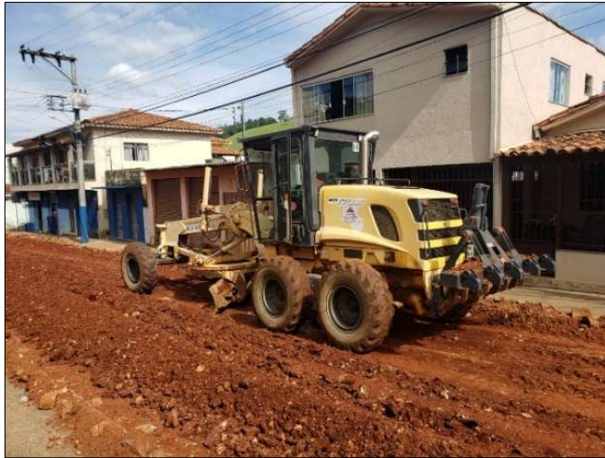
Figura 23: Motoniveladora no centro da cidade de Capitólio - MG.
