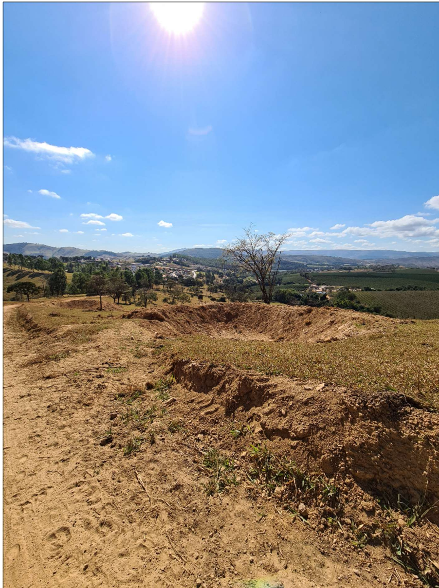
Figura 57: Imagem antes, no momento da intervenção no trecho Facãozinho do Ambrósio.
