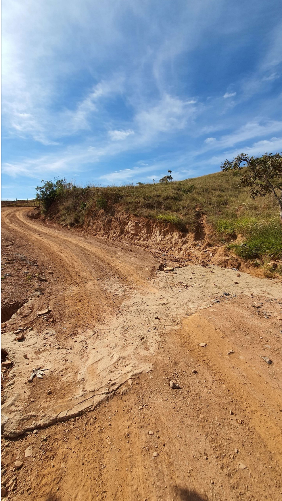
Figura 54: Imagem atual, após a intervenção, no trecho Morro do Chapéu do Ambrósio.
