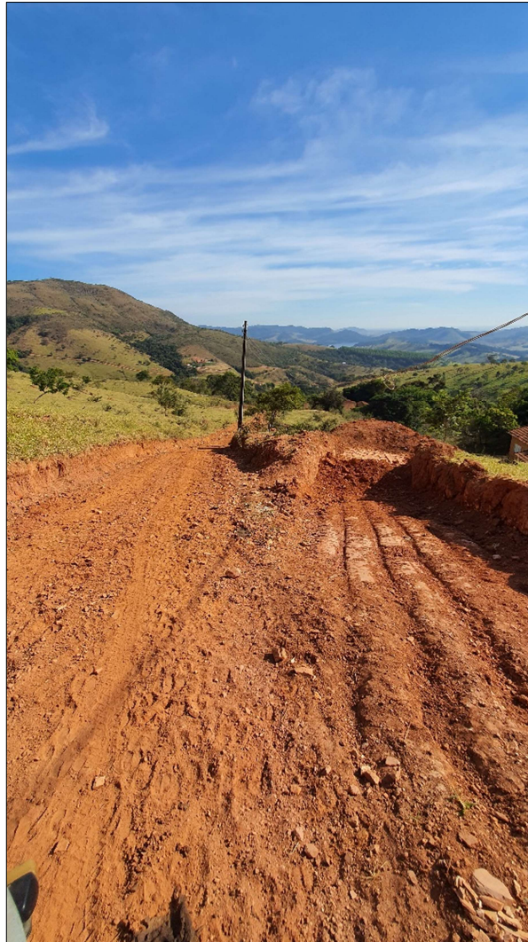
Figura 52: Imagem atual, após a intervenção, no trecho Morro do Chapéu do Ambrósio.
