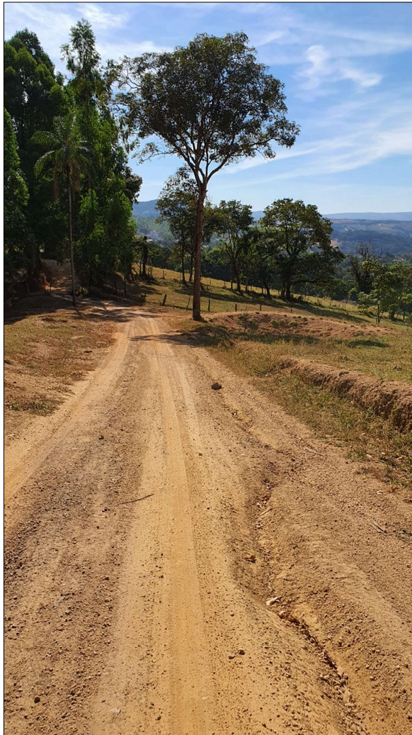
Figura 58: Imagem atual, após a intervenção, no trecho Facãozinho do Ambrósio.
