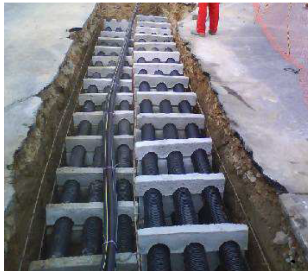
Figura 8 – Instalação de dutos para as redes subterrâneas (CELESC, 2020).
