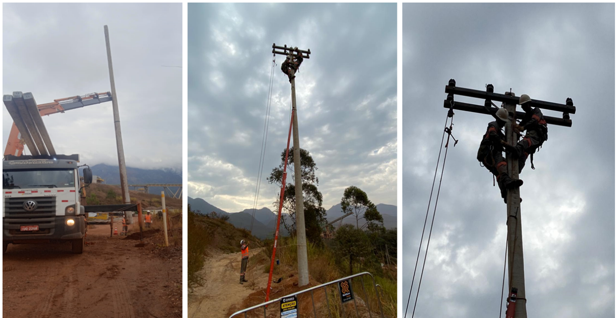
Figura 17 – Instalação dos postes da rede redundante (Autoria própria).
