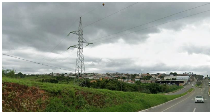
Figura 6 - Rede de transmissão 138 kV que alimenta a cidade de Formiga-MG.
