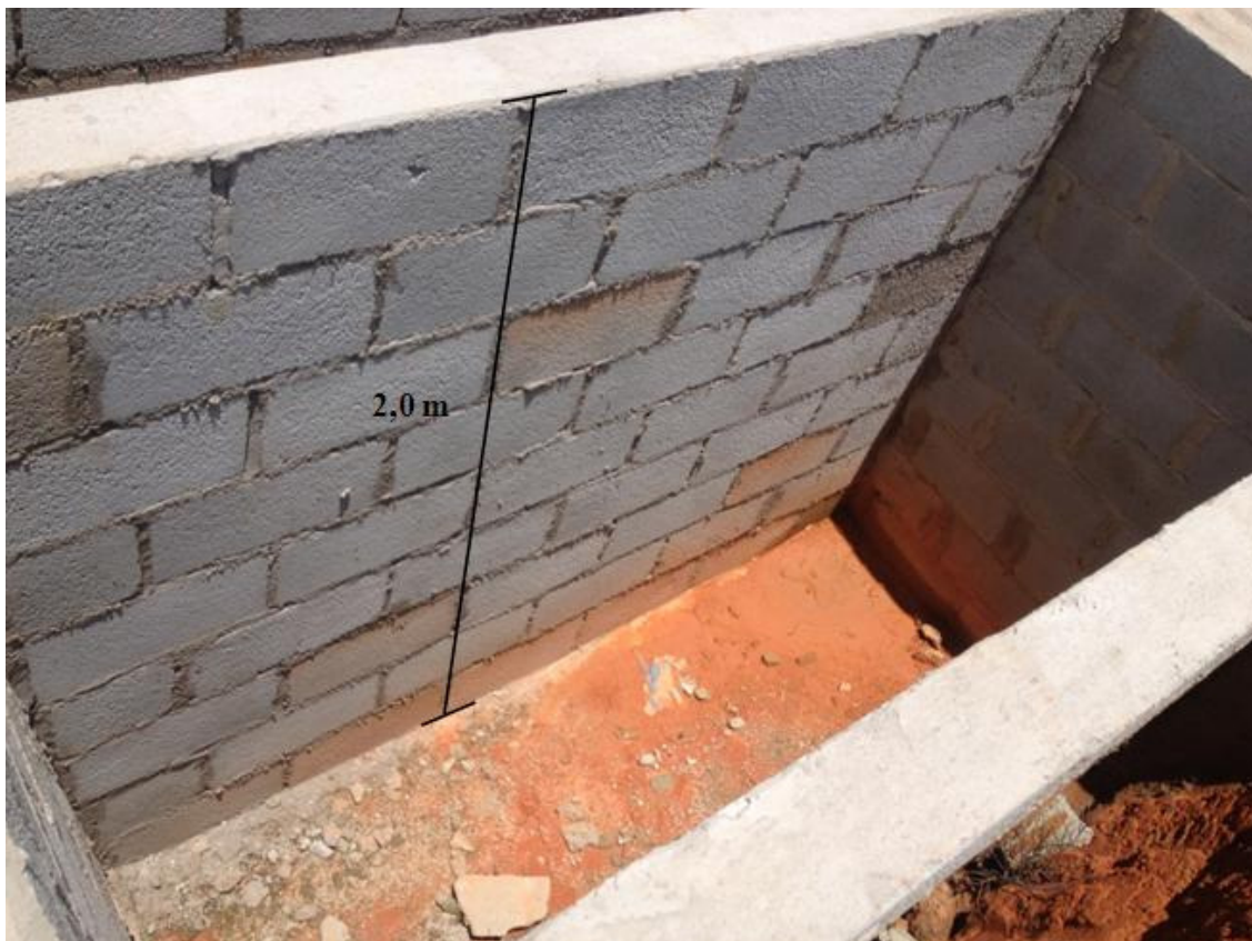
Figura 5.4: Jazigo típico sem fundo impermeabilizado no cemitério Municipal Parque Cachoeira, Betim-MG
