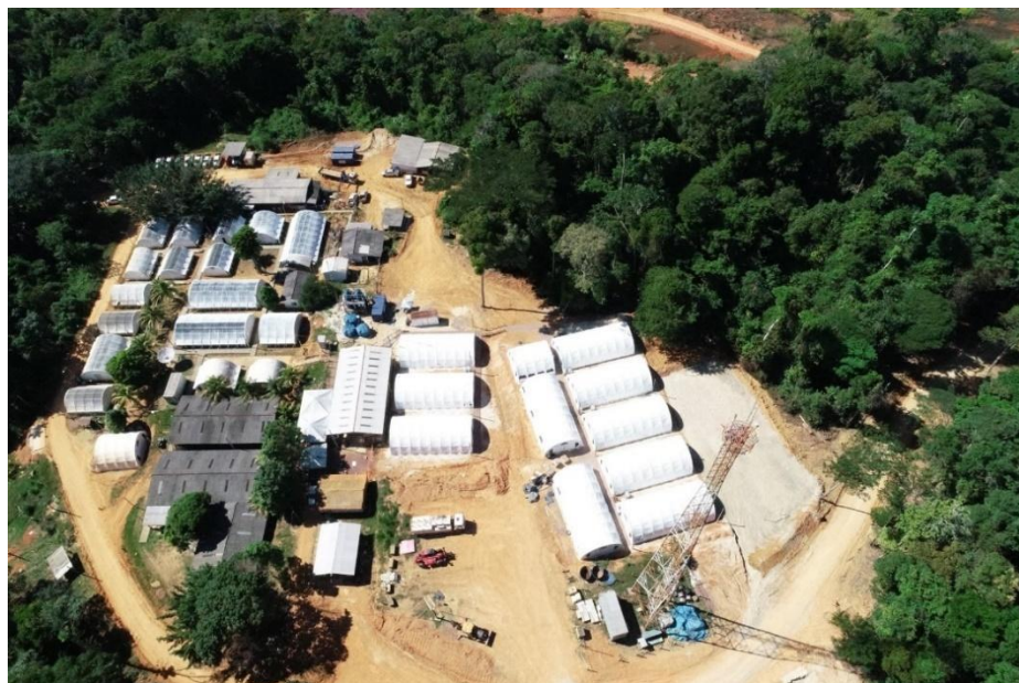
Figura 2. Instalações do projeto “Tocantinzinho” na região de antigos garimpos no sudoeste do estado do Pará. Fonte: Clam Meio Ambiente, 2022b.
