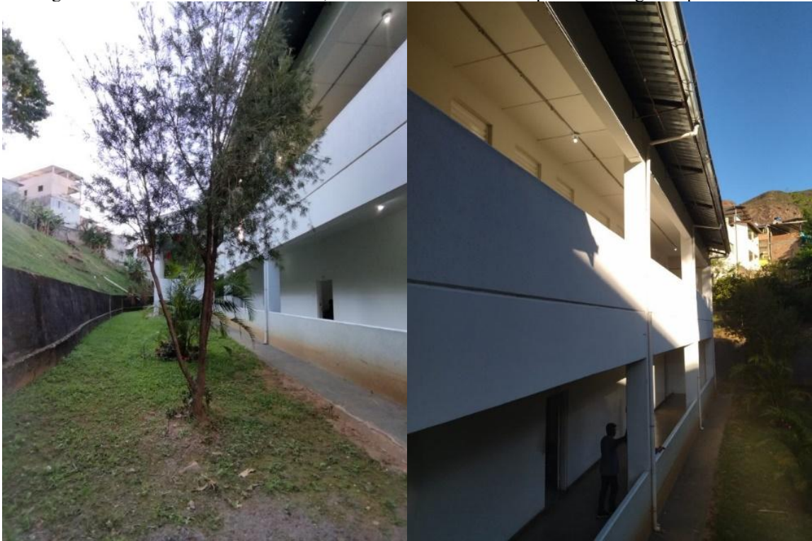
Figura 3a e 3b: Vista de trás da escola, corredores de acesso entre primeiro e segundo pavimentos.
