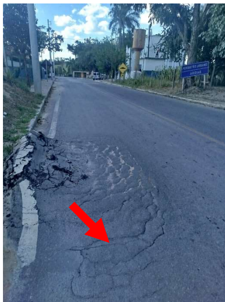
Figura 49 – Trincas
