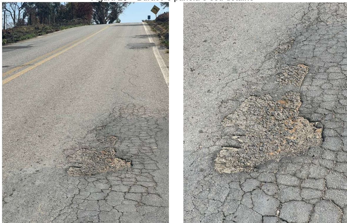
Figura 26 – Buraco e panela e seu detalhe
