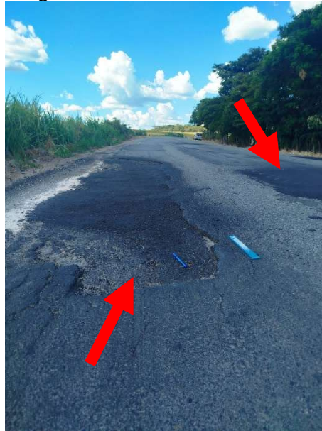
Figura 46 – Panela e remendos
