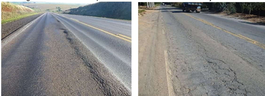
Figura 9 – Afundamento plástico e afundamento de consolidação
