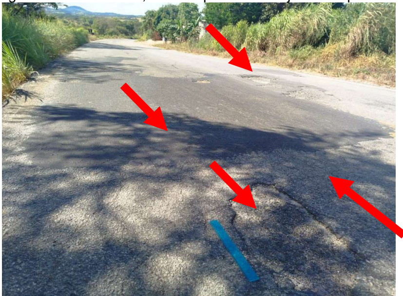
Figura 64 – Remendos, trincas tipo “couro de jacaré” e panelas
