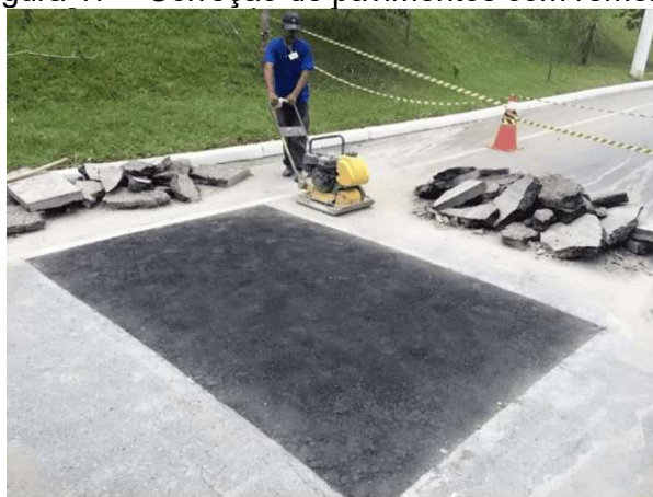
Figura 17 – Correção de pavimentos com remendo
