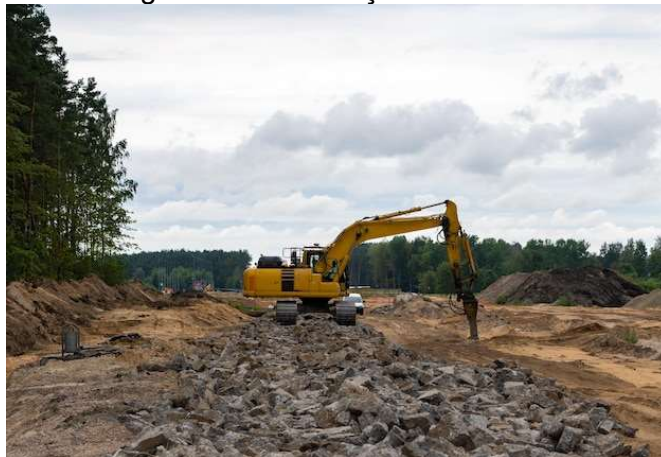
Figura 19 – Demolição de estrada
