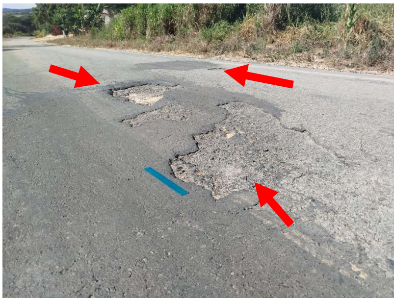
Figura 63 – Painelas e remendos
