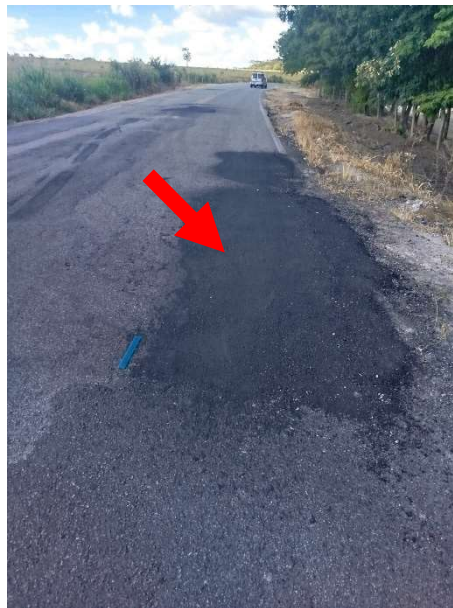
Figura 47 – Remendo
