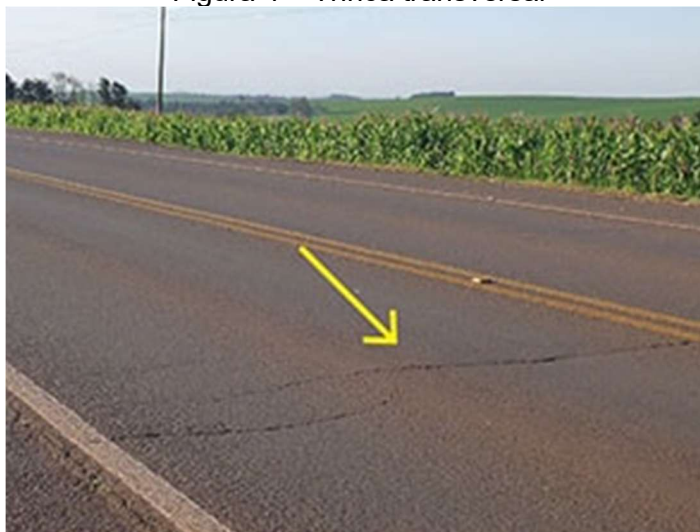
Figura 4 – Trinca transversal
