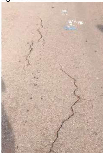
Figura 5 – Trinca transversal
