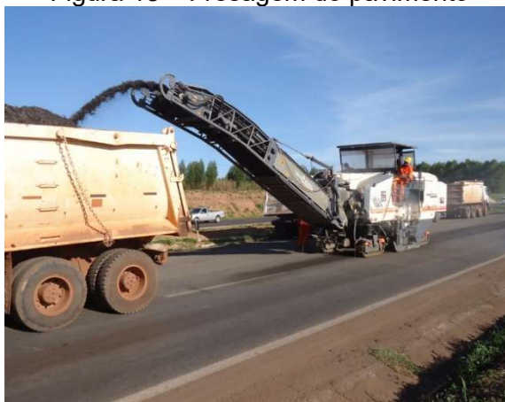
Figura 18 – Fresagem do pavimento
