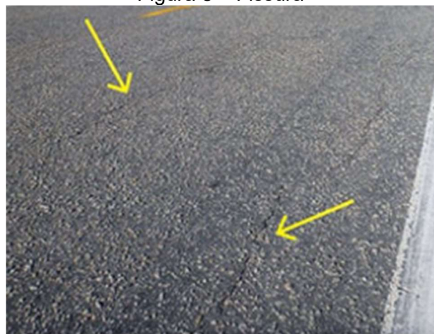
Figura 8 – Fissura
