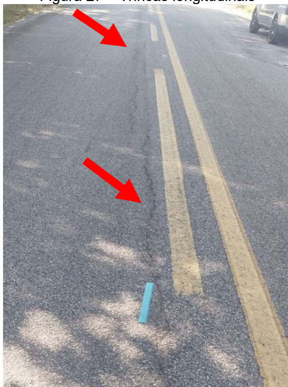
Figura 27 – Trincas longitudinais
