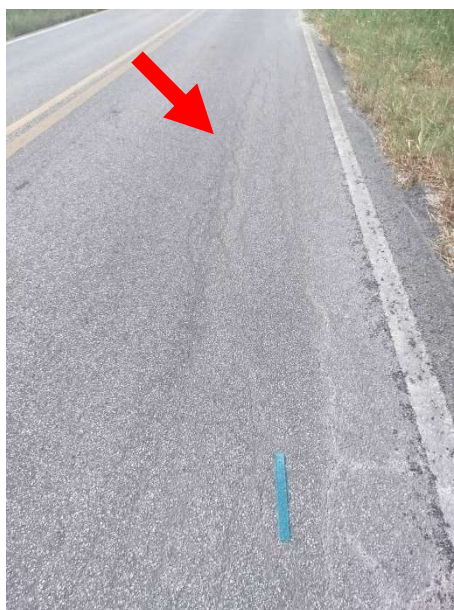
Figura 51 – Trincas
