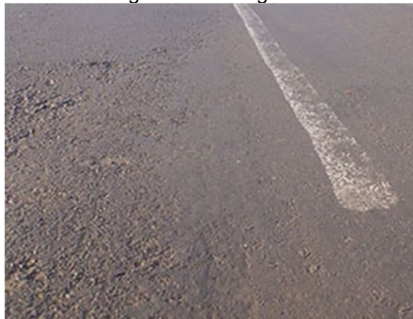
Figura 13 – Desgaste
