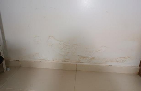
Figuras 06 e 07: Descascamento e estufamento da pintura. Fonte: Autoras (2023).
