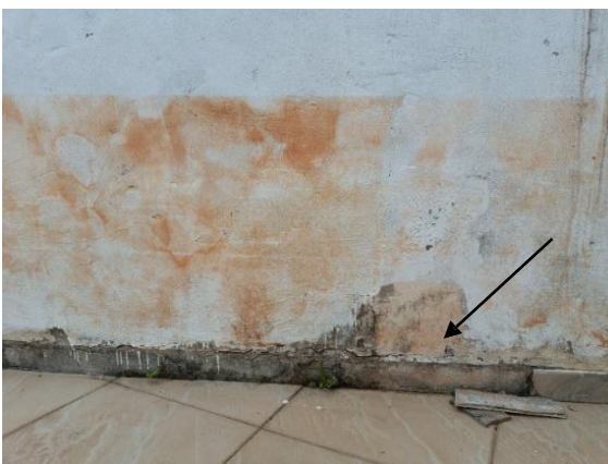
Figuras 10 e 11: Deslocamento de revestimentos. Fonte: Autoras (2023)
