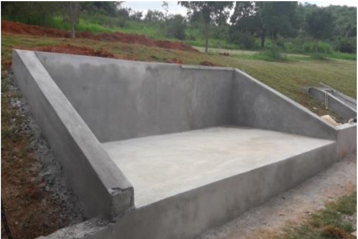
Figura 20 - Finalização da obra da base para instalação dos reservatórios.
