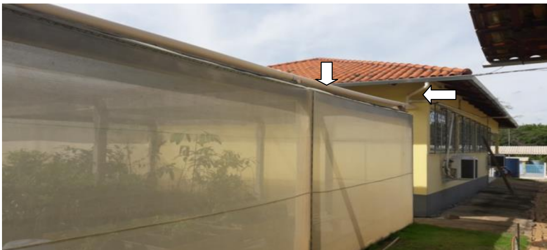
Figura 26 - Fotos das tubulações do prédio principal
