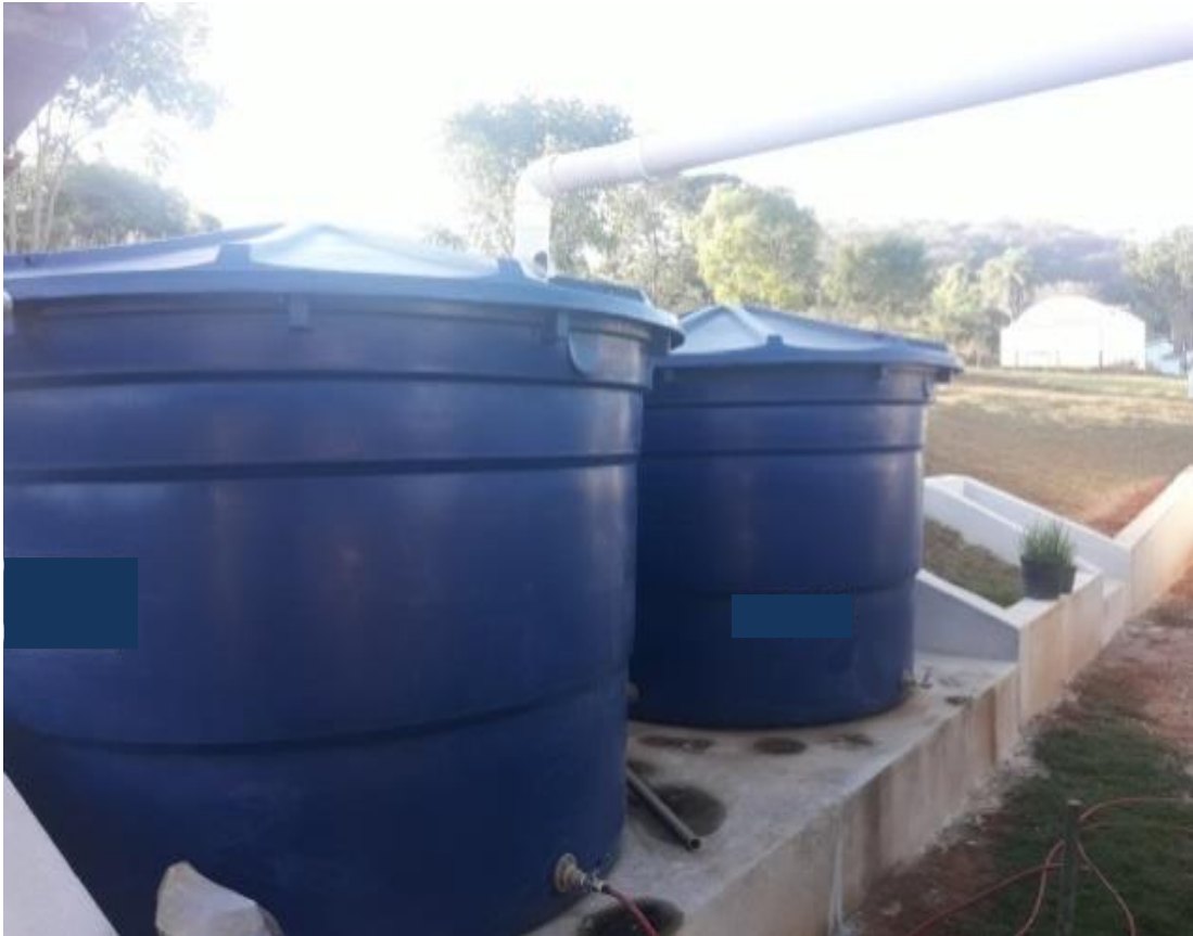
Figura 27 - Finalização da instalação do projeto
