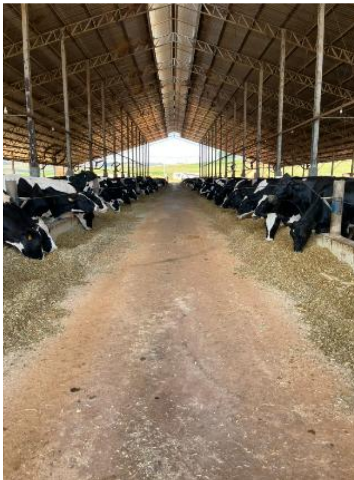
Figura 5: Pista de alimentação do sistema
