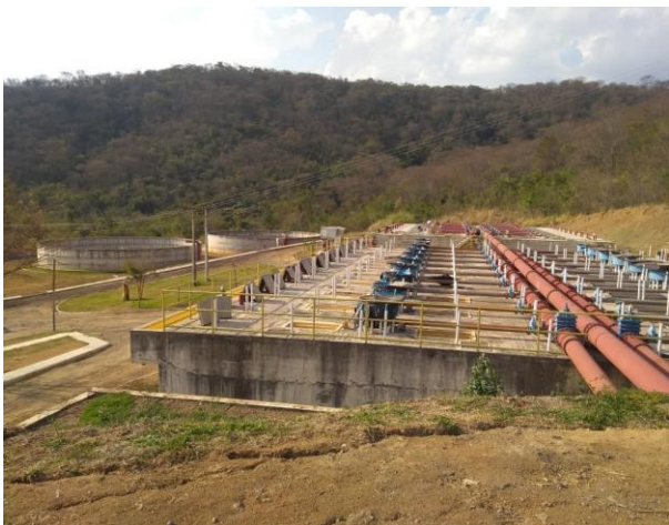
Vista parcial da ETE (em obra) de Itaúna - MG (22/08/2019)
