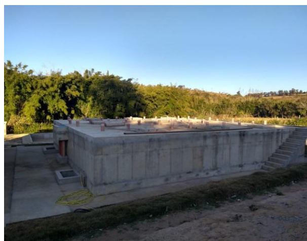
Vista parcial da ETE (em obra) de São Francisco de Paula – MG (23/07/2019)
